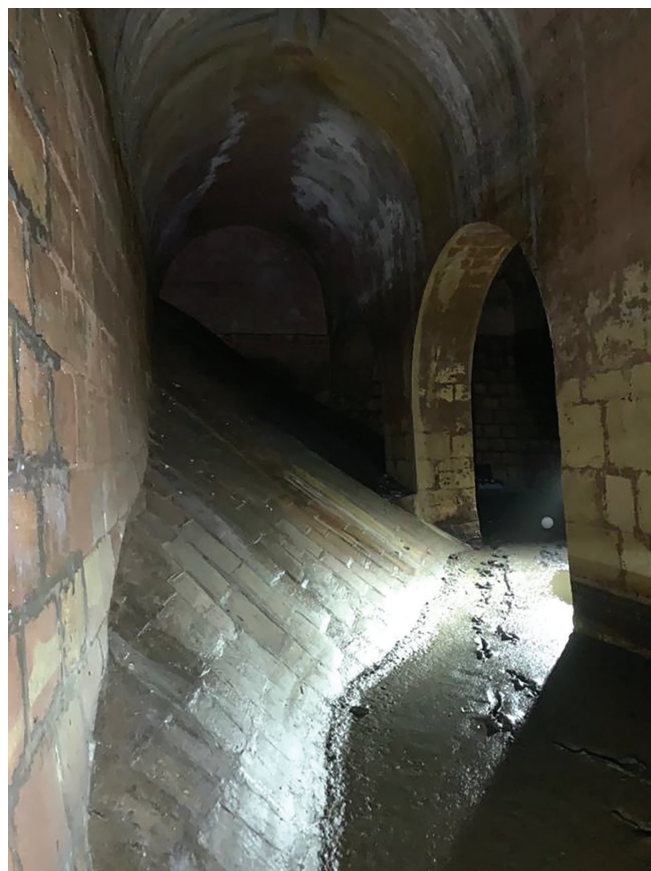
Figura 4. Interior de la cisterna con el revestimiento moderno. Autoría propia.
