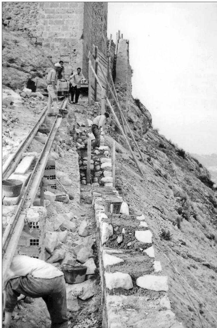
**Fig. 13.** Adaptación durante las obras de restauración de la década de 1960: instalación de una vagoneta entre los recintos superior e inferior para el transporte de material.
