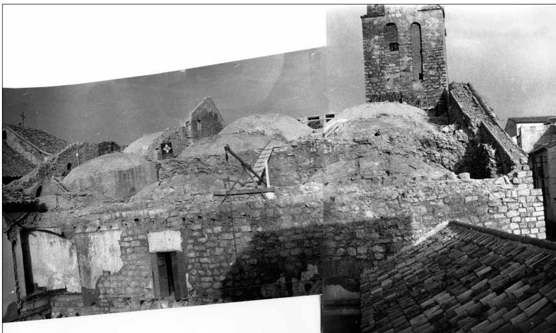
Lám. 17. Aspecto general de la iglesia tras el desmontado de su cubierta, donde se pueden ver las distintas bóvedas aún sin consolidar el extrados (Foto Higinio)
