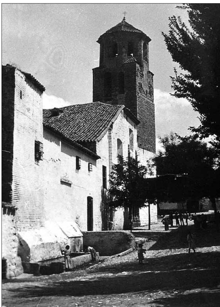
Lám. 25. La iglesia de La Magdalena a comienzos del siglo XX, donde puede apreciarse en primer término el volumen del cuerpo inferior del alminar. Obsérvese igualmente el zócalo de arranque del alminar y una fuente a sus pies
