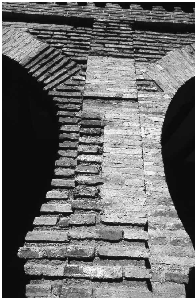
Láms. 34 y 35. La arquería recuperada y convenientemente restaurada diferenciando las fábricas existentes de las restituidas, destruidas con la disposición de huecos adintelados
