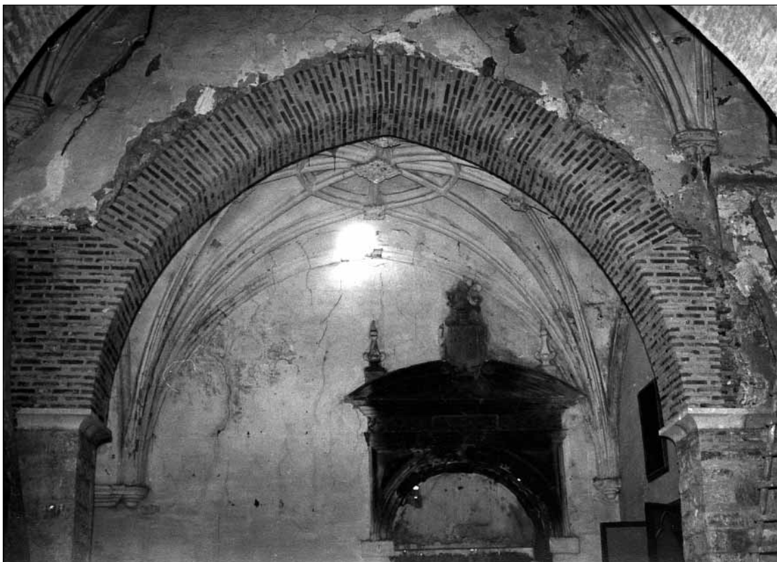
Lám. 12. Arco restaurado con fábrica de ladrillo
