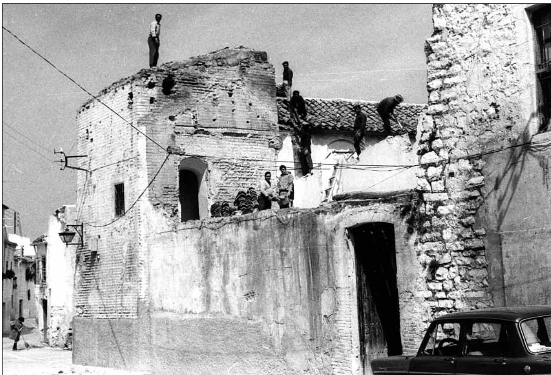
Lám. 24b. Demolición de los muros que ocultaban el volumen del alminar. Parte de su coronamiento fue destruida para crear una cubierta con pendiente a la calle
