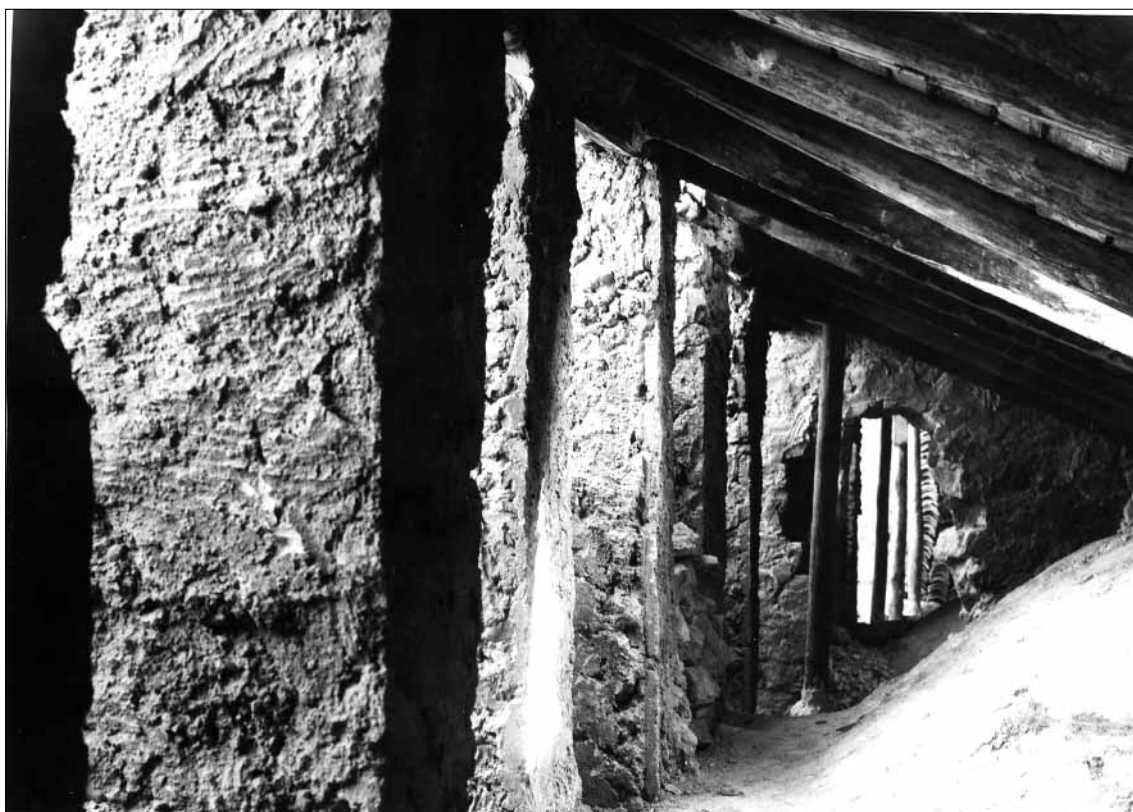
Lám. 15. Organización de la cubierta de rollizos de madera sobre pilares enanos, montados sobre la fila de arcos bajo ellos (Foto Ortega. Septiembre 1971)
