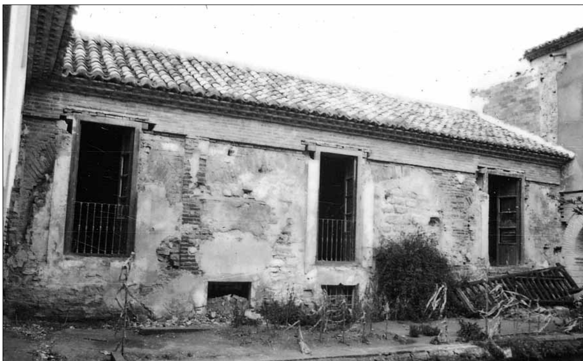
Lám. 31. Edificación en el lado Norte del patio, tras demoler la planta sobre ella. En el muro de fachada se descubrieron restos de una arquería semidestruida y cegada
