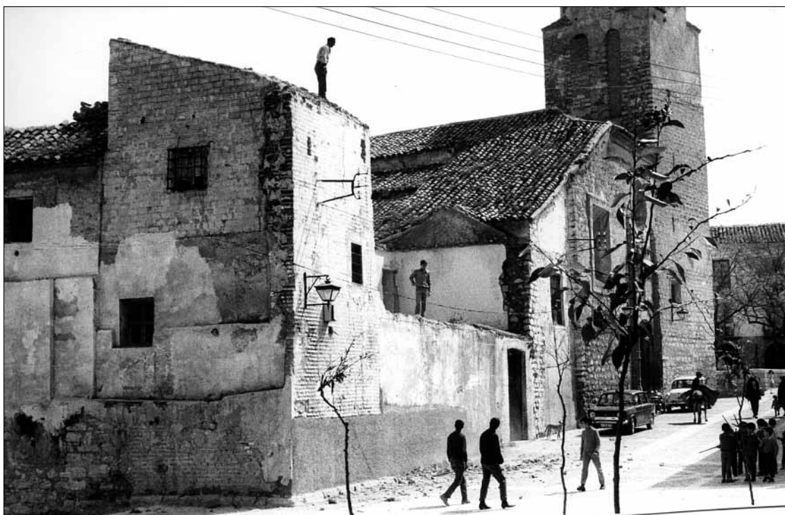
Lám. 24a. Demolición de los muros que ocultaban el volumen del alminar. Parte de su coronamiento fue destruida para crear una cubierta con pendiente a la calle
