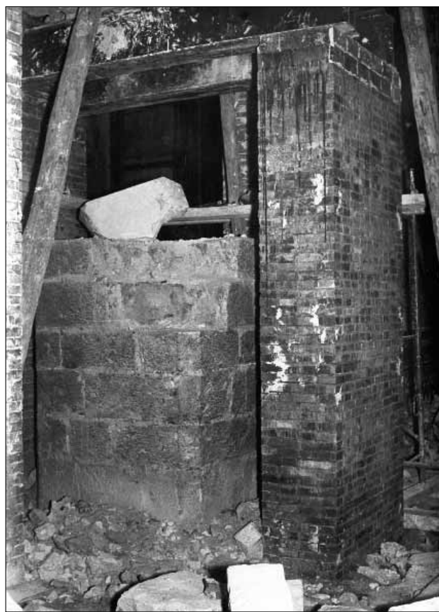
Lám. 9. Trabajo de demolición de uno de los pilares de las naves, previo apeo de los arcos que soportaba (Foto Higinio)
