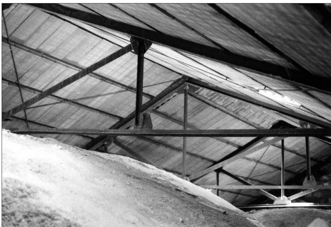
Lám. 19. Aspecto de la nueva cubierta en su tramo central con cerchas metálicas
