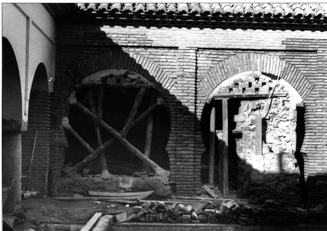
Láms. 32 y 33. Proceso de restauración de la arquería descubierta semidestruida, cegada con la mampostería del muro
