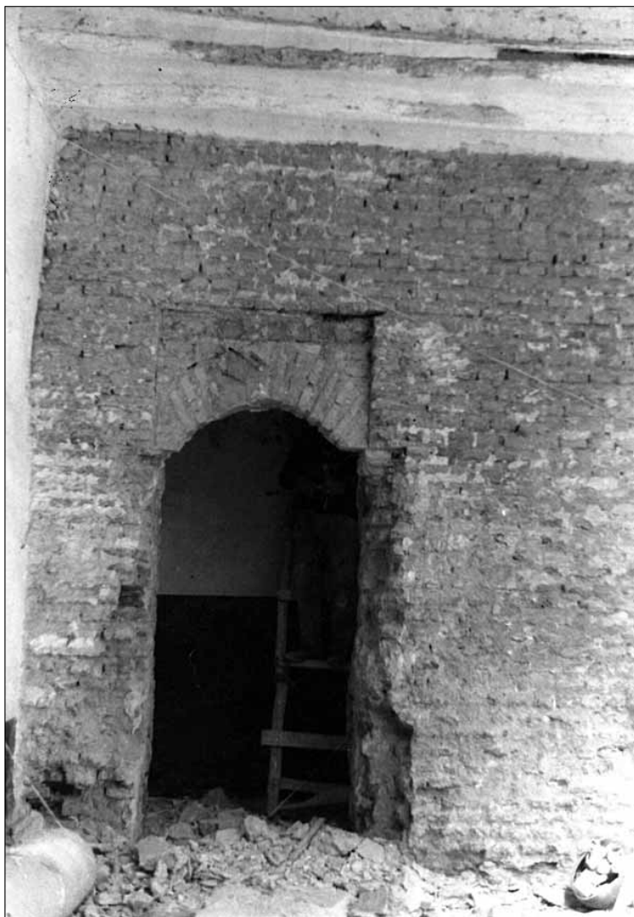
Lám. 26. Picado del revoco que cubría la fábrica original del alminar, con los restos del hueco de acceso desde el patio. Obsérvese el rebaje del alfiz
