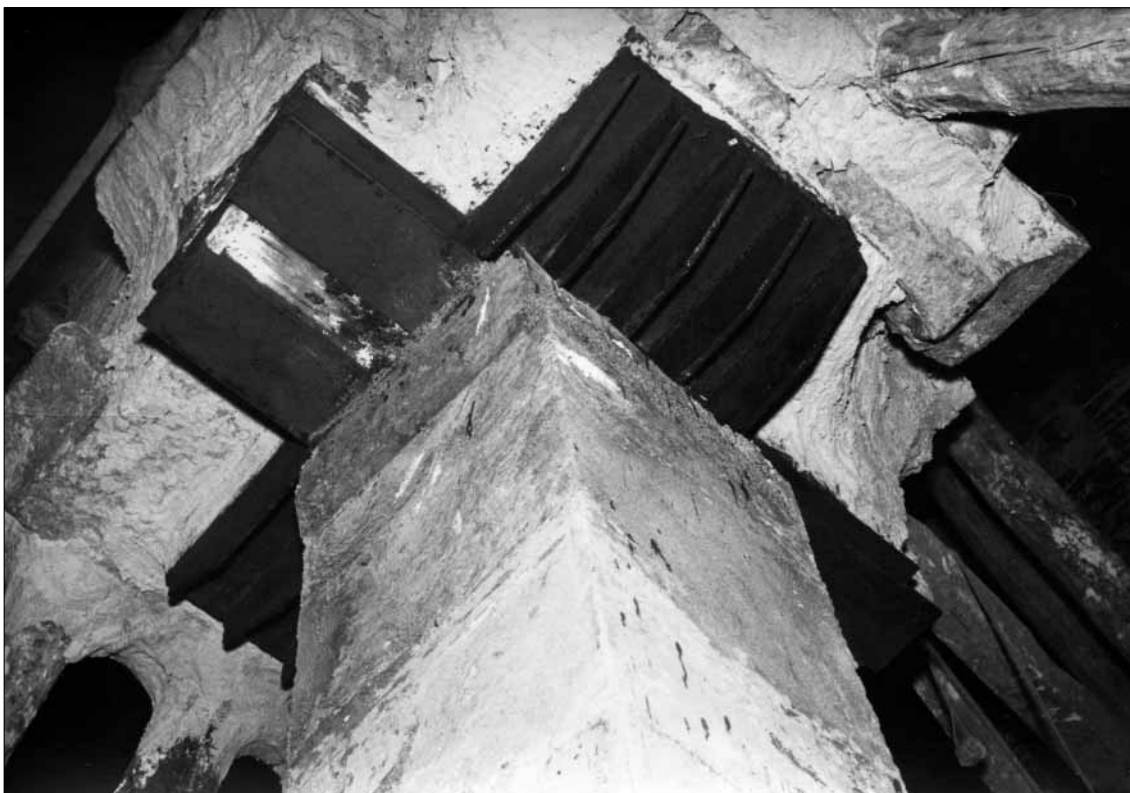
Lám. 10. Pilar de hormigón y capitel metálico bajo el cimacio, antes de ser revestido con los sillarejos que presentaba (Foto Higinio)
