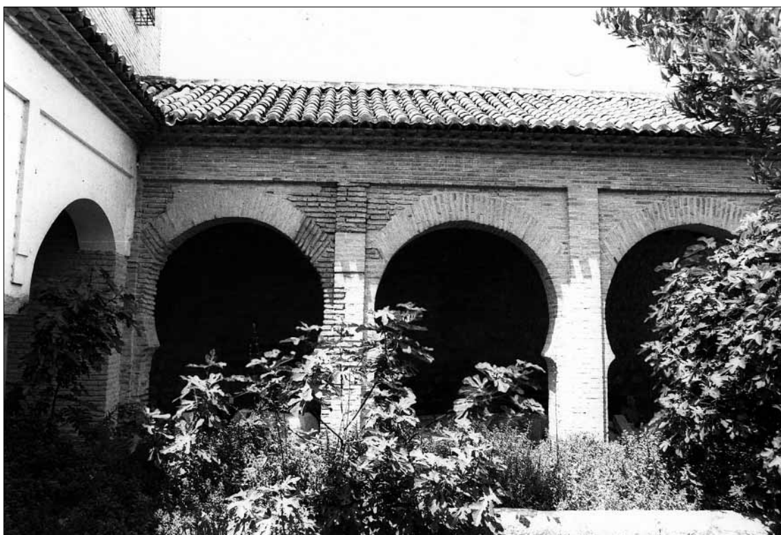
Láms. 34 y 35. La arquería recuperada y convenientemente restaurada diferenciando las fábricas existentes de las restituidas, destruidas con la disposición de huecos adintelados
