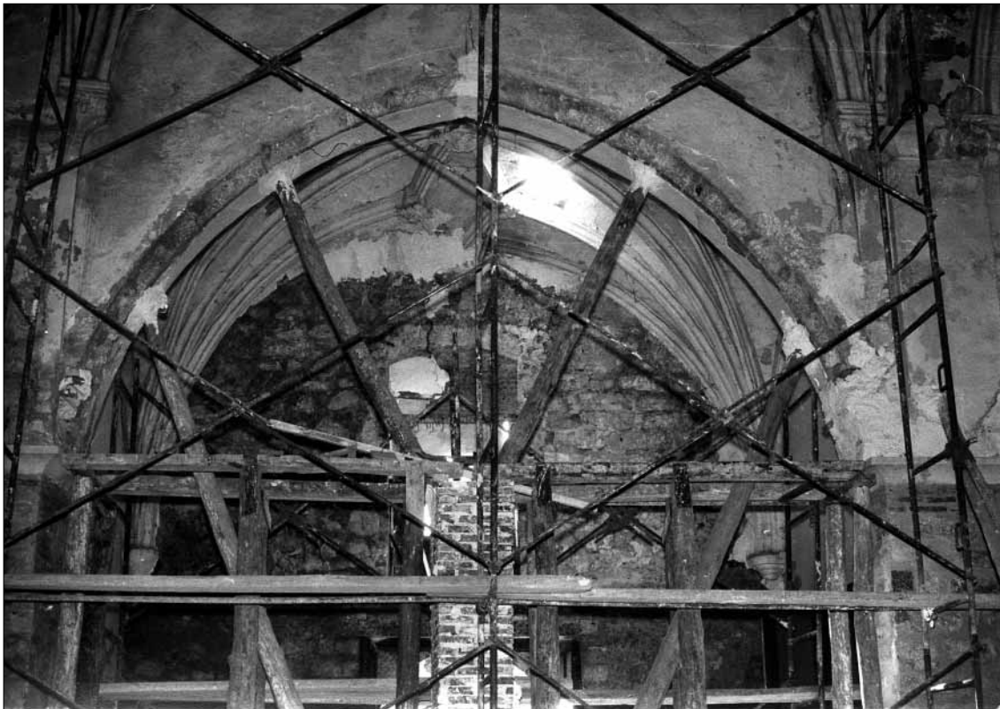
Lám. 11. Arco apuntalado para ser reconstruido con fábrica de ladrillo, tras el montaje de un camón de madera apoyado en un pilar provisional de fábrica de ladrillo recuperable (Foto Higinio)
