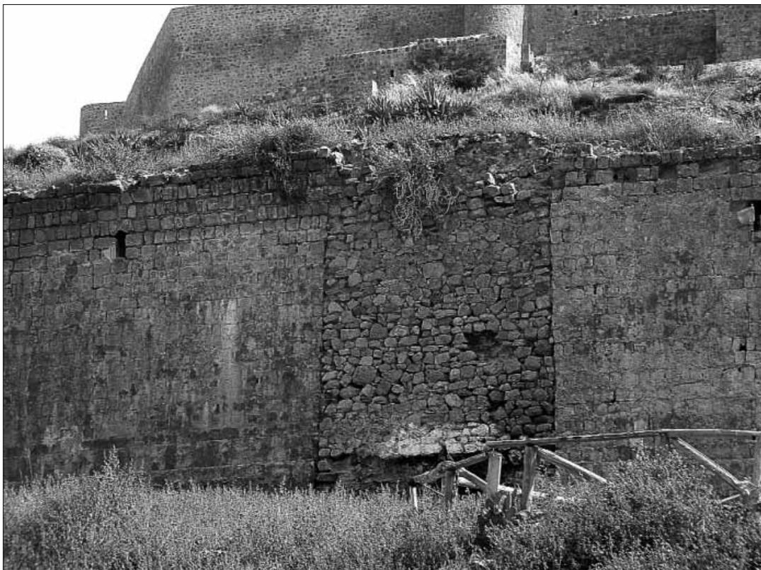
**Lam. 18.** *Detalle de la destrucción de una torre de tapial, cuyo hueco fue revestido con mampostería.*
