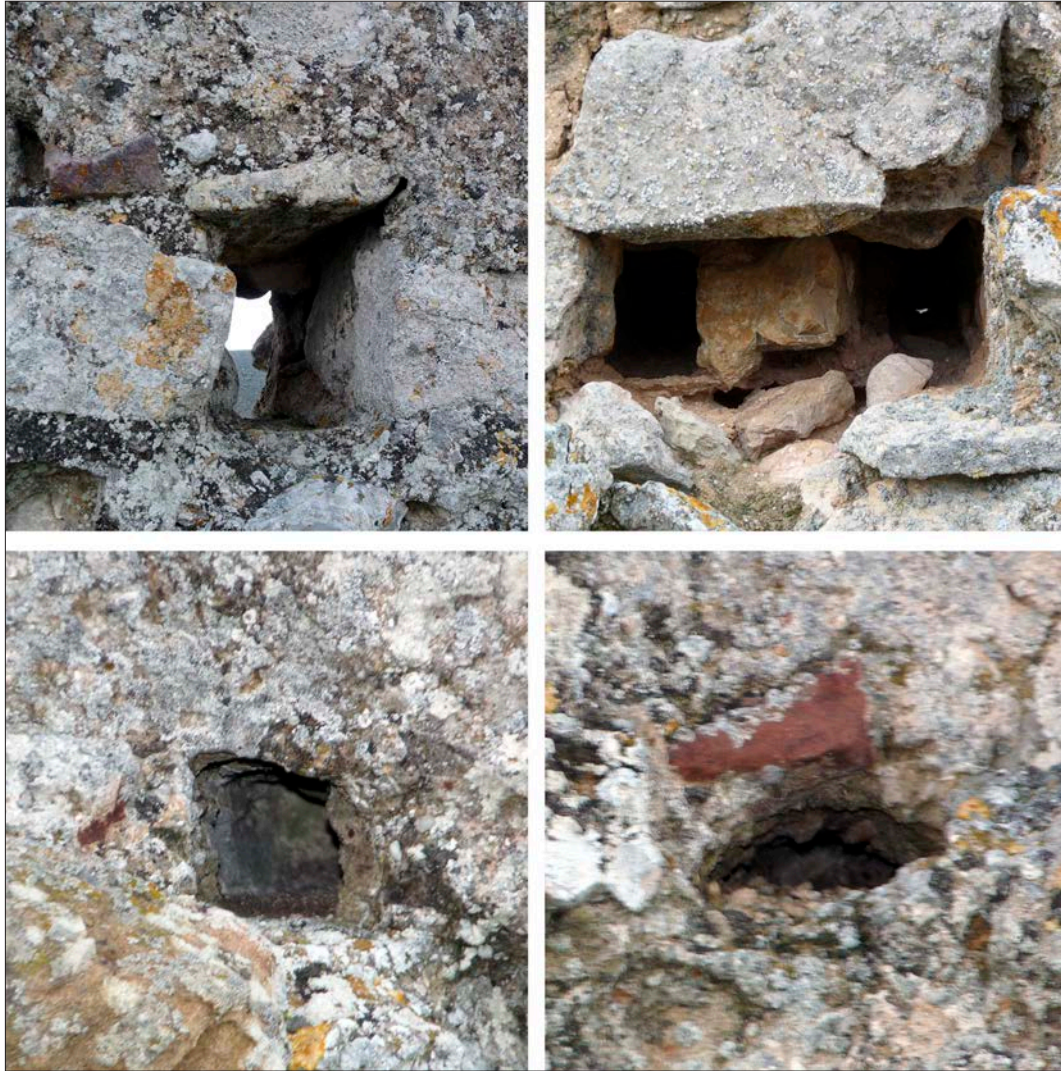
Figura 8. Mechinales del muro M3. a. Mechinal rectangular y pasante del tramo septentrional. b. Mechinales rectangulares pareados correspondientes a una junta constructiva. c. Mechinal de sección cuadrangular en el tramo medio. d. Mechinal correspondiente a una media aguja formada por un rollizo fajado en el tramo meridional.
