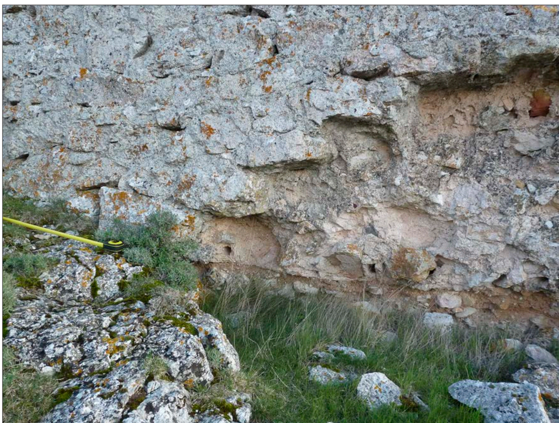
Figura 4. Detalle de la parte baja del muro M1a del lienzo noroccidental de las murallas de Peñalcázar donde se aprecian los mechinales de las agujas de la fábrica de tapia de cal y canto que rellena el espesor del muro.
