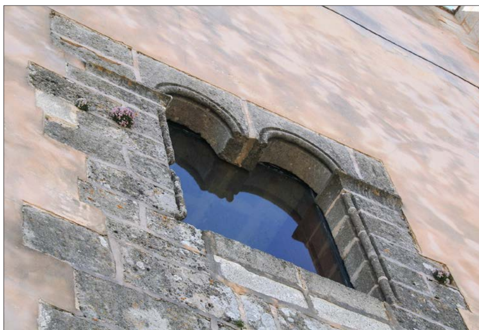
Figura 22. Detalle de una de las ventanas geminadas de la Torre Gótica del Castell donde se aprecian las arcadas curvas que forman los arcos de la apertura.
