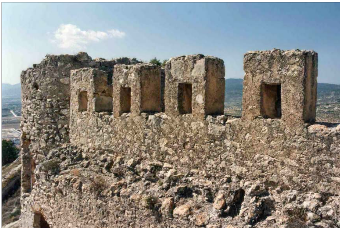
Figura 31. Almenado aspillerado de la crestería de la domus medieval del Castell de Castalla.
