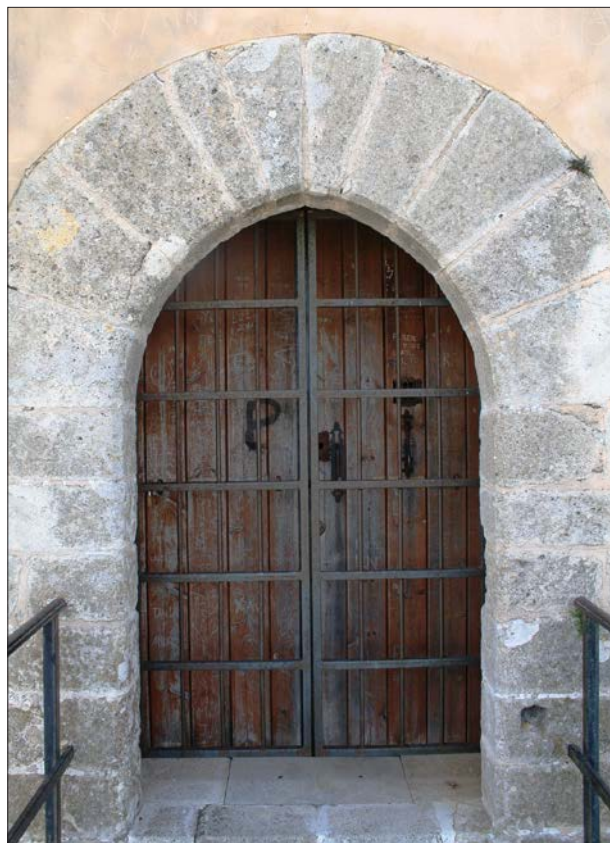
Figura 20. Detalle de la Puerta de ingreso a la Torre Gótica del Castell donde se aprecian los volsors que conforman el arco superior y los umbrales que forman el vano de acceso.
