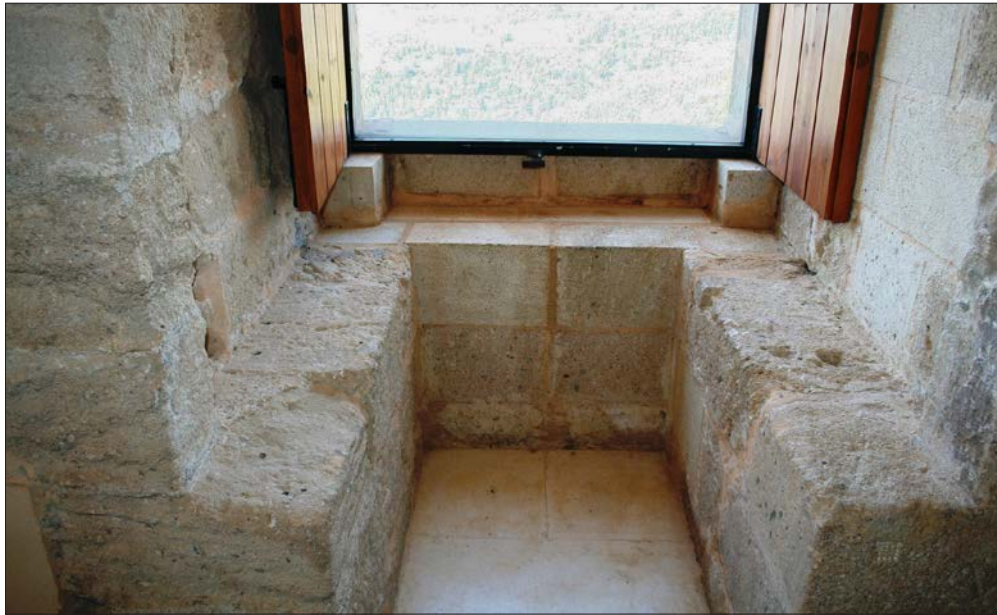
Figura 25. Detalle del interior del festejador de una de las ventanas de la Torre Gótica del Castell de Cocentaina.
