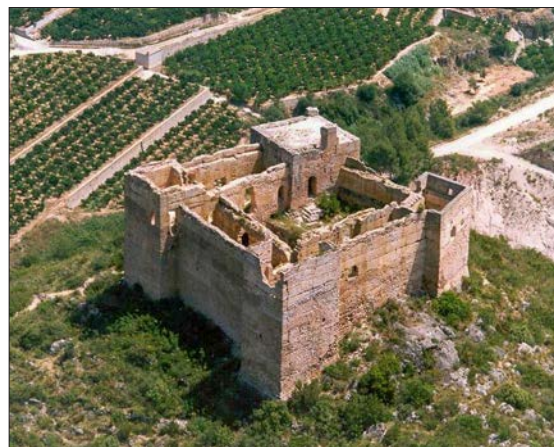
Figura 15. Vista aérea de la domus medieval del Castell de Forna (L'Atzúvia).
