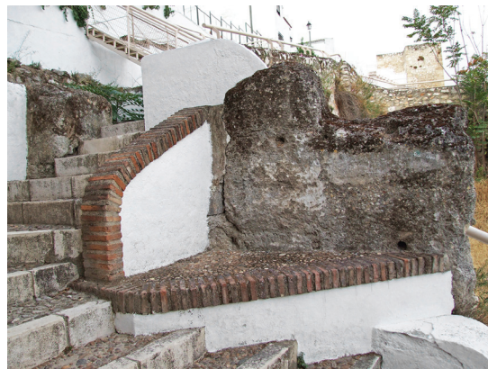
Fig. 13. Portillo oriental (letra J) de la transición entre los sectores Alcazaba y Jaufín, abierta en los paños de tapial de hormigón de la muralla zirí.
