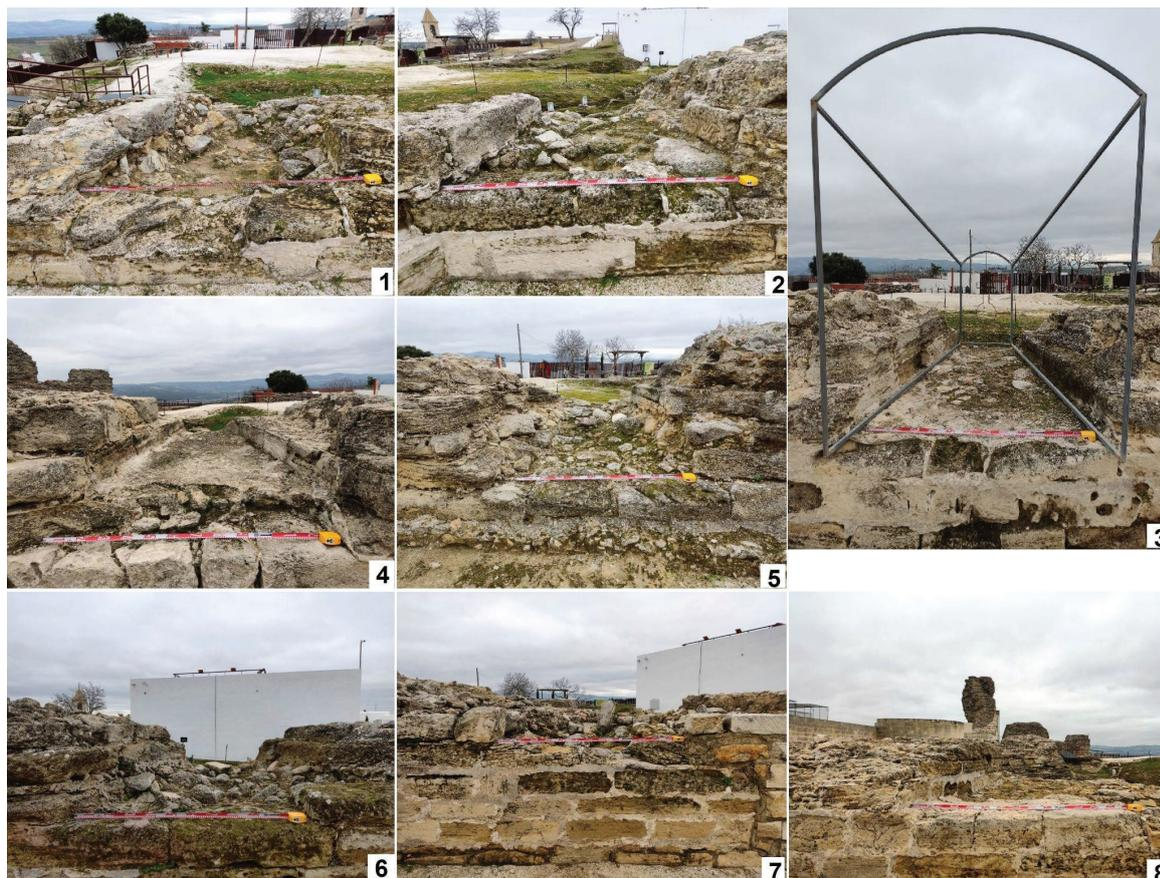
**Fig. 4.** Detalles de las troneras de la falsabraga desde el lado oriental, numeradas por orden de norte a sur, desde la torre del Homenaje a la de la Mazmorra. En la tronera n.º 3 se ha hecho una recreación mediante una estructura metálica para permitir una mejor interpretación.
