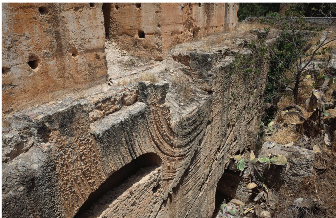
Figura 11. Gran noria de al-Muṣāra en Fez la Nueva. Cajeado para el apoyo de la rueda y huellas de rotación.
