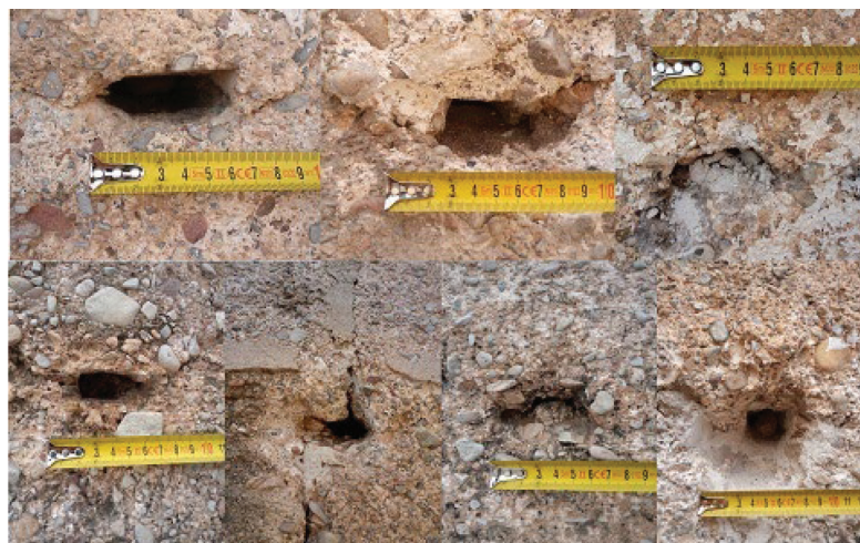
Figura 20. Diversos tipos de agujales documentados (fotografías m. Sánchez)
