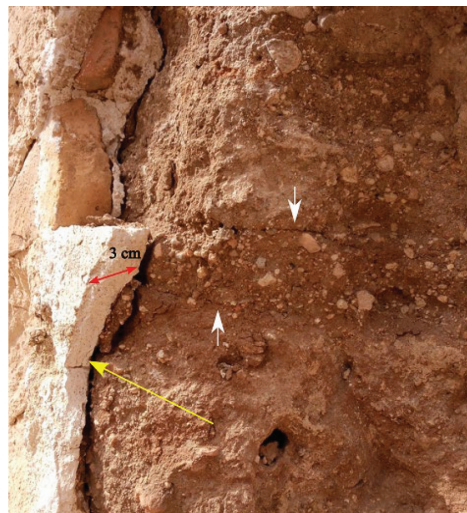
Figura 17. Tapia tipo 3, de la que se ha desprendido la costra de mortero (fotografía M. Sánchez). Se observa su grosor (flecha amarilla) y las línea de tongadas del ánima de la tapia (flechas blancas)
