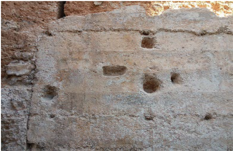
Figura 18. Improntas de construcción de época contemporánea y marcas originales de tablonos de caja identificadas en el paramento interior norte (fotografía M. Sánchez)
