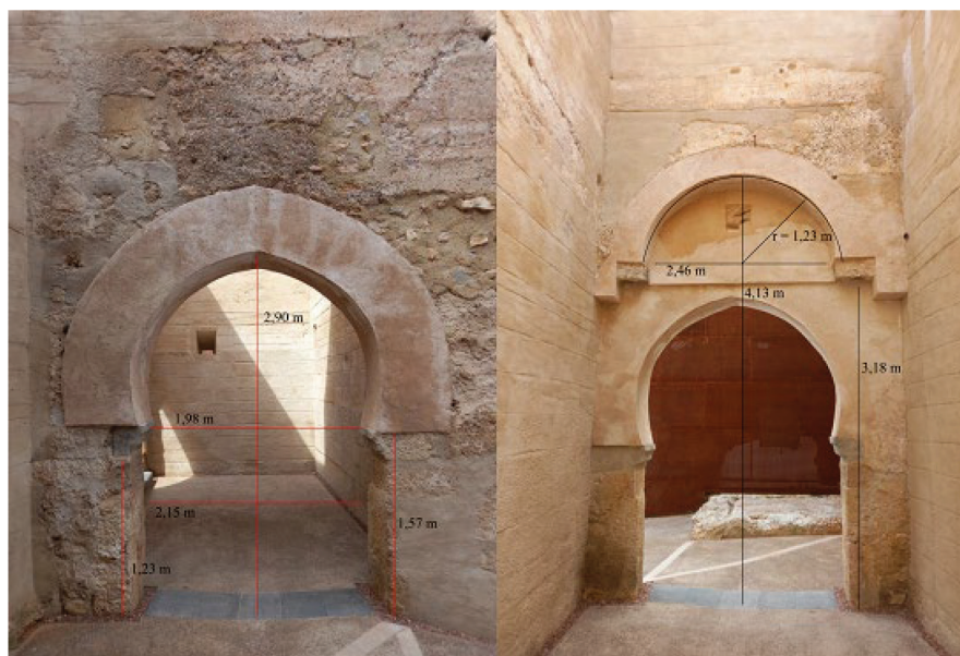
Figura 10. A la izquierda, puerta este desde el exterior y, a la derecha, sistema del doble arco desde el interior, con indicación de sus dimensiones y con posterioridad a los trabajos de recuperación de 2020-2021 (archivo Ayuntamiento de Llíria)
