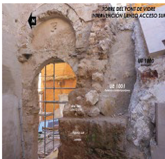
Figura 14. Excavación en el hueco entre la torre y la placeta Juan de Austria, que permitió documentar una parte conservada de la trasera del edificio y de la muralla medieval; véase en el corte la composición de la tapia tipo 1 (fotografía M. Vicente Gabarda)
