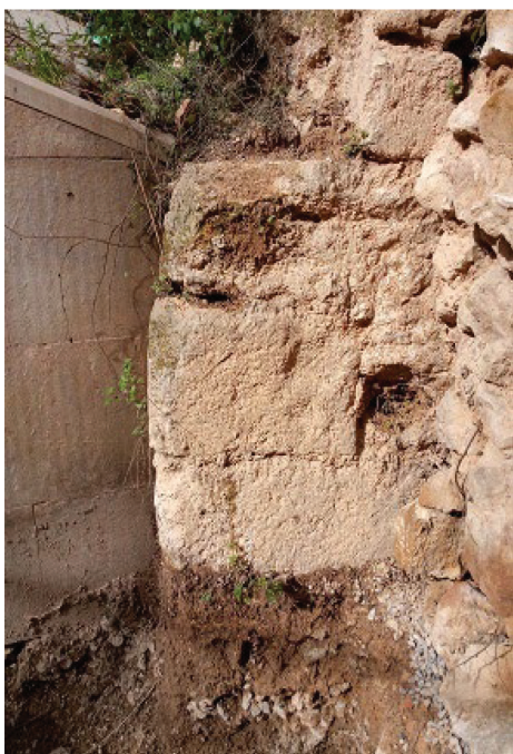
Figura 19. Jamba oeste del acceso sur, de grandes sillares de arenisca y, en uno de ellos, la roza del alamud (fotografía M. Sánchez)
