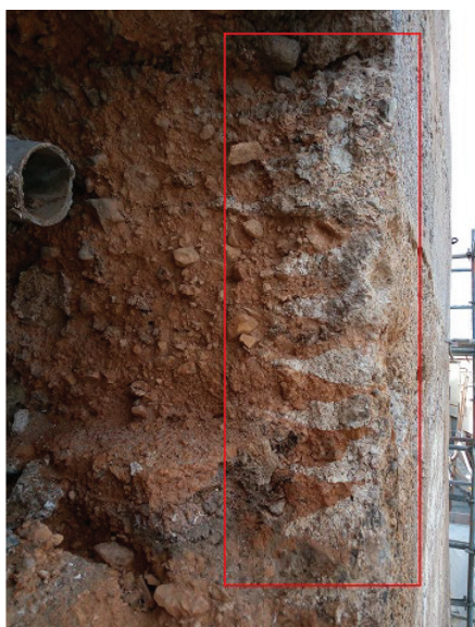
Figura 16. Tapia tipo 2 con áridos (fotografía M. Sánchez). Véanse las cuñas de mortero de cal por tongadas (recuadro rojo)
