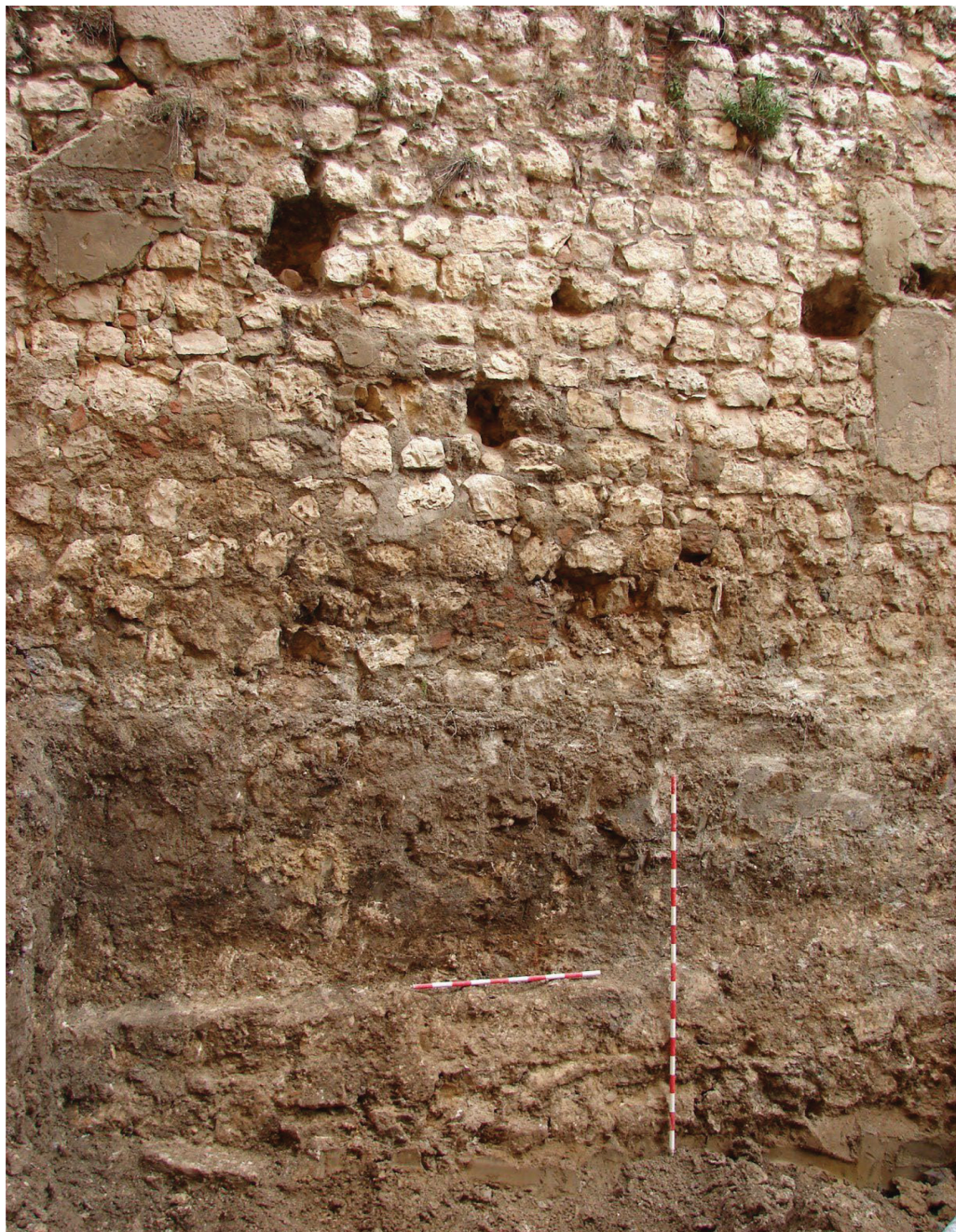
Figura 4. Lienzo y cimentación de la muralla intramuros en el solar situado al norte del arco de San Juan, tras la intervención arqueológica.
