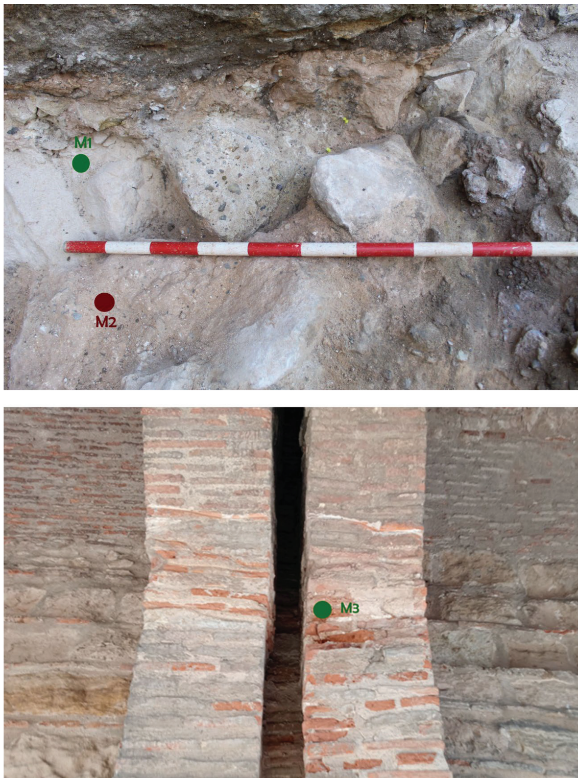
Figura 8. Lugar de procedencia de los morteros de cal analizados de los distintos cuerpos de fábrica: base de cimentación del cubo norte (M1), estructura cuadrangular adosada (M2) e intradós del arco central (M3).
