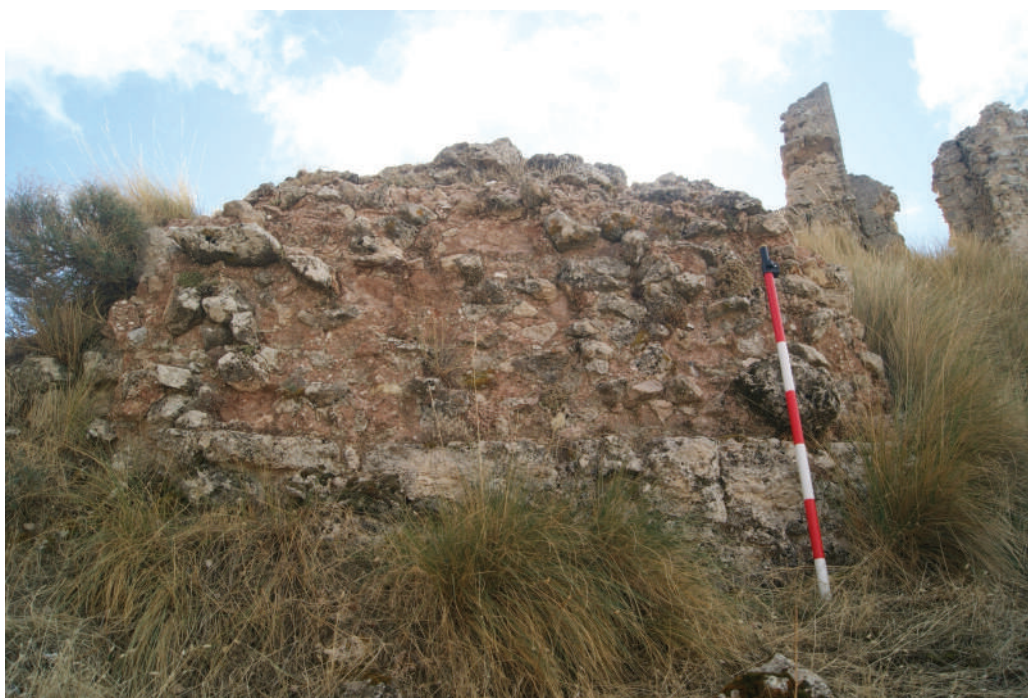
Figura 5. Muralla de mampostería no concertada trabada con mortero de yeso (UE 123). Fuente: los autores.
