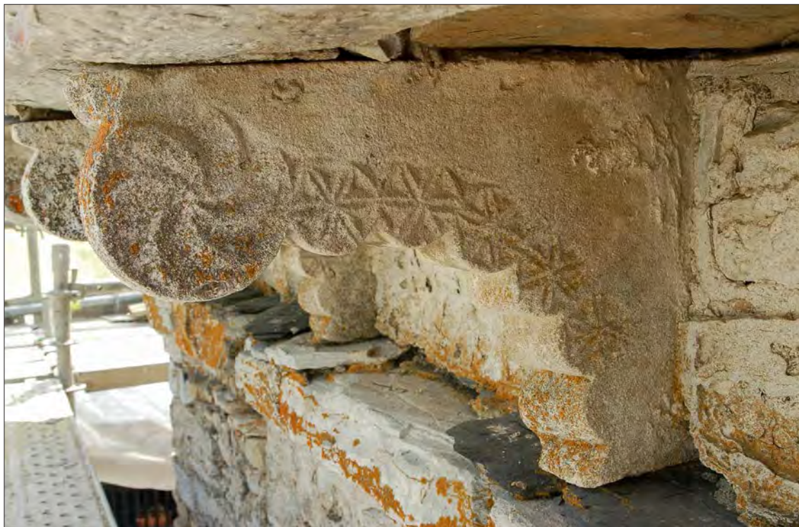
Fig. 14. Modillón polilobulado del alero del tramo oriental aula correspondiente a la fase 1 (A100, UE1074: Modillón número 27)
