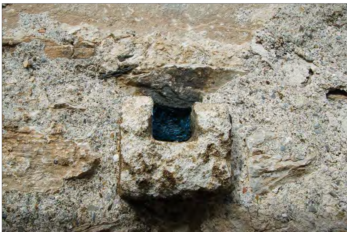
Fig. 5. Desagüe del bajocubierta del ábside oriental
