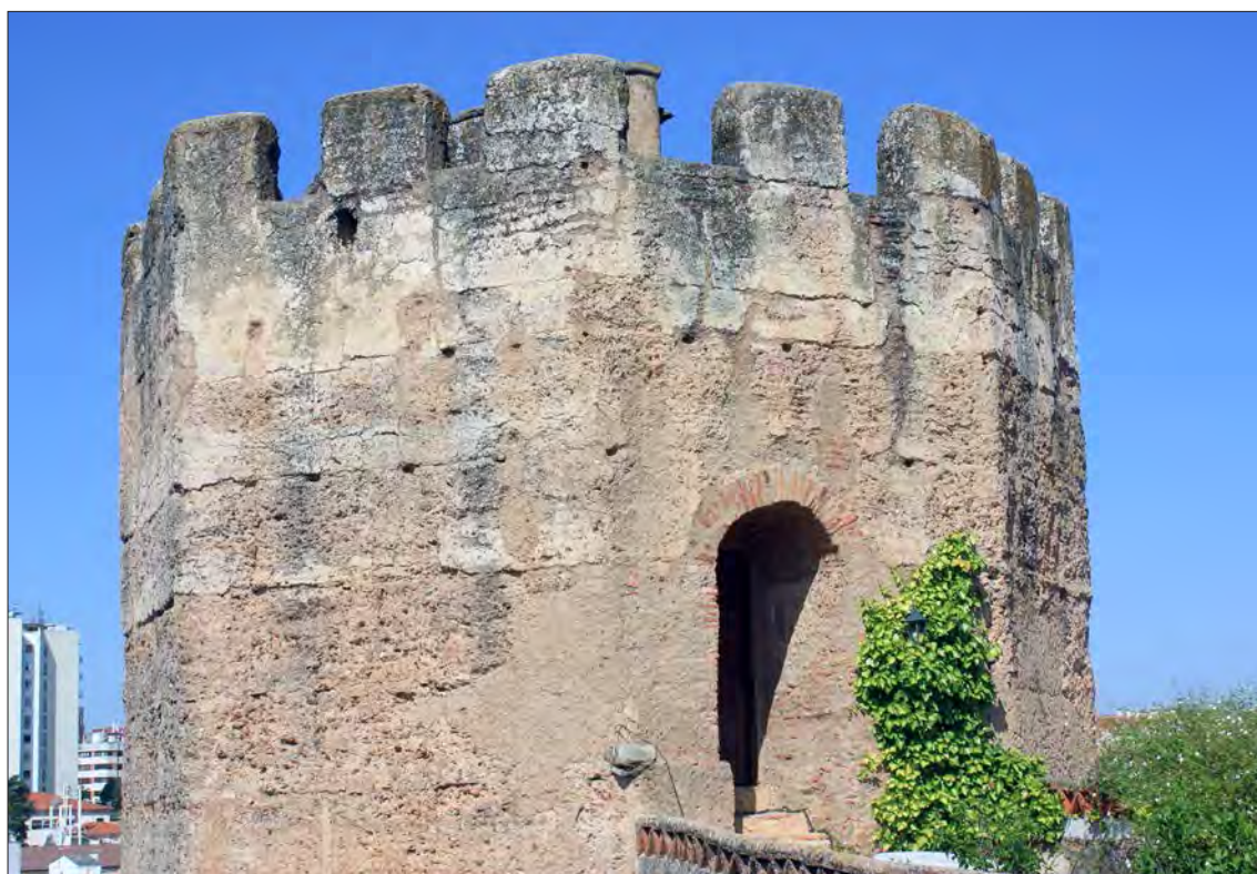
Lám. 15. Parte superior de la Torre Redonda desde el este. Obsérvese, por debajo del pretil de la albarrana, la estrecha hilada de ajuste parcialmente cubierta por los restos de la jabelga que también se aplicó al pretil y la merlatura.
