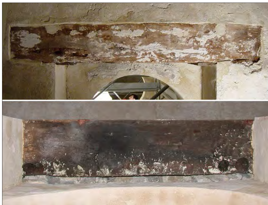
Fig. 12. Descargadero de madera de la puerta de acceso a la habitación sur (arriba), costado vertical, y norte (abajo), base.
