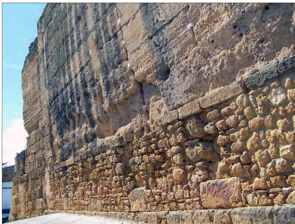
Lám. 21. Lienzo almohade del recinto de Carmona.
