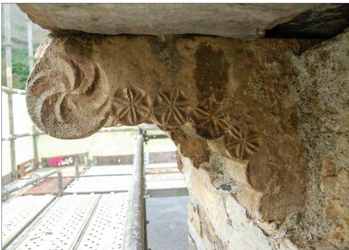
Fig. 17. Modillón polilobulado del alero del tramo oriental del aula con la decoración de los últimos modillones sin acabar correspondiente a la fase 2 (A124, UE1076: Modillón número 15)
