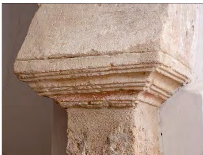
Fig. 30. Hérmedes de Cerrato, cimacio del arco de embocadura del ábside, Nuestra Señora de las Heras.
