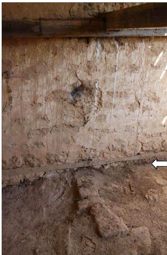
Fig. 7. Viga de madera documentada en el testero oriental del aula de San Miguel de Escalada (flecha indicando su posición en parte baja)
