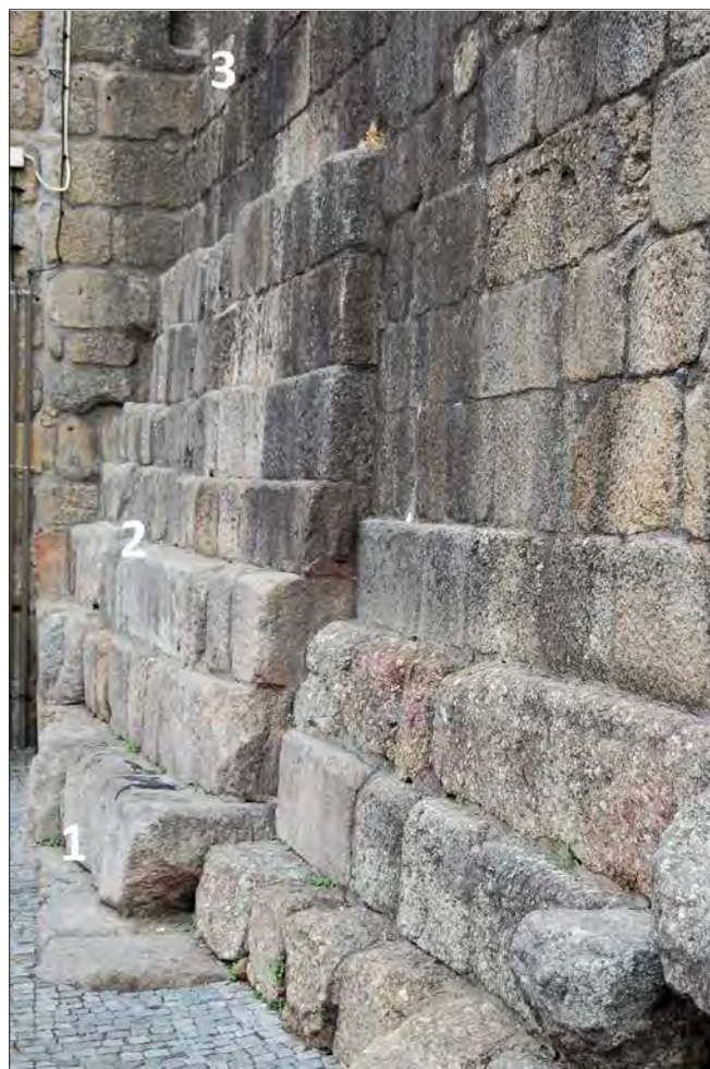
Fig. 12. Sé de Viseu, Varanda dos Cónegos. Pormenor do aparelho construtivo do alicerce na face meridional, com indicação de três fases construtivas. 1: muro romano que seguia uma orientação Noroeste-Sudeste; 2: muro de provável cronologia alto-medieval; 3: muro de cronologia baixo-medieval.
