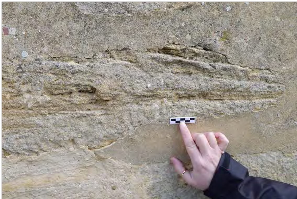
Fig. 13. San Miguel de Escalada, alzado norte. Mampuesto de conglomerado cementado, obsérvese la laminación y estratificación cruzada propia de estos niveles
