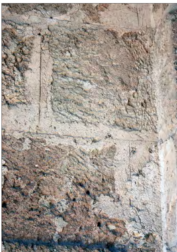
Lám. 14. Detalle del interior de la almohade Puerta de Sevilla, en Niebla. Destaca la presencia del aparejo fingido que contrasta con la discreta presencia de las incisiones cortas en diagonal.
