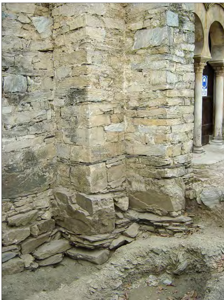
Fig. 24. Cimientos de la fachada meridional del ábside occidental constructivamente unitarios con el ángulo suroccidental del aula
