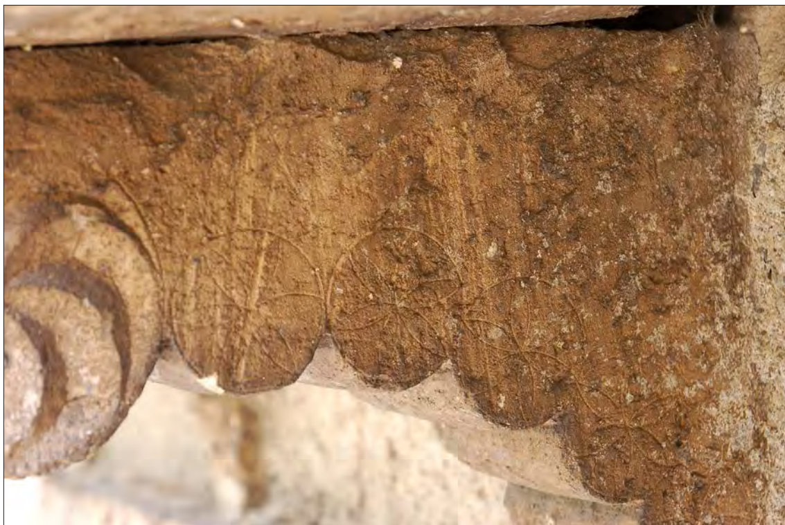
Fig. 16. Modillón polilobulado del alero del tramo oriental del aula donde reconocemos la traza a punzón de su esquema decorativo sin acabar correspondiente a la fase 2 (A124, UE1073: Modillón número 4)
