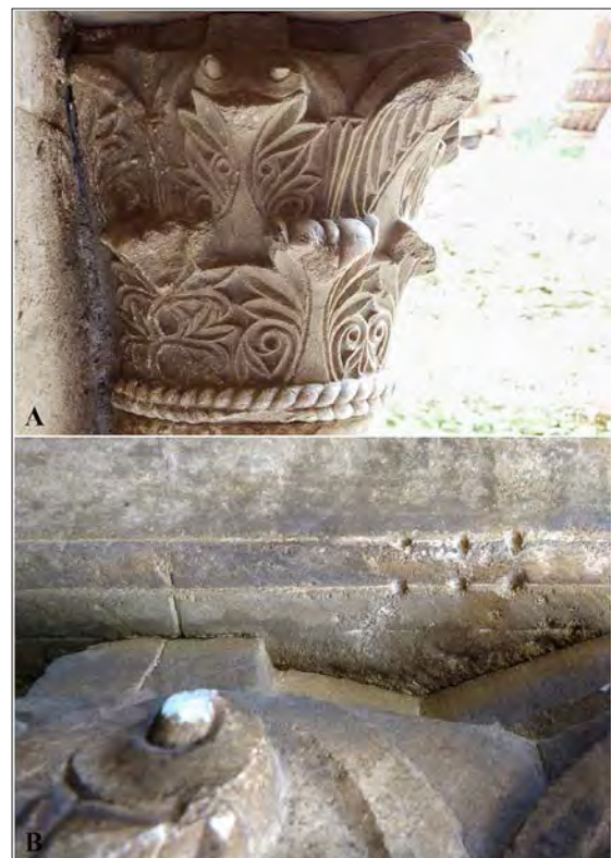
Fig. 15. Santiago de Peñalba. Capitel E de la portada S, vista interior (A). Capitel y cimacio E de la portada S, marcas de ajuste (B).
