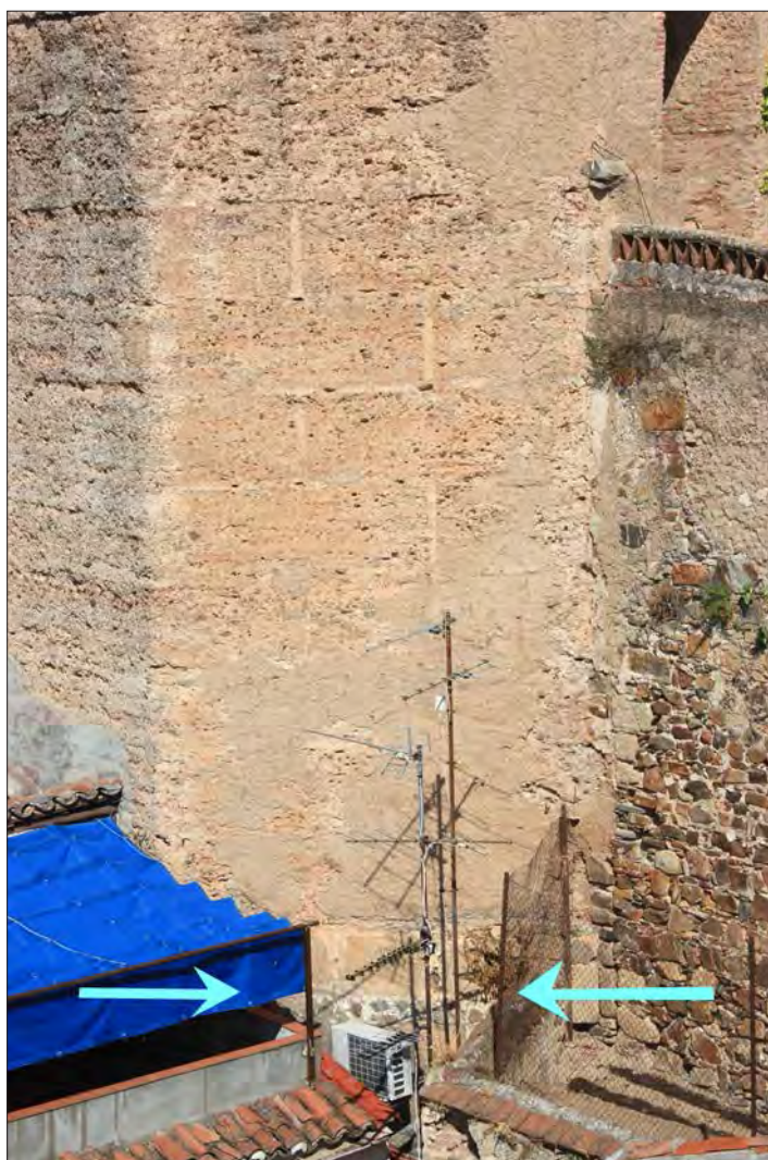
Lám. 10. Cara oriental de la Torre Redonda. La línea imaginaria trazada entre las flechas indica el límite entre el prisma octogonal y el plano triangular inclinado que queda por debajo. Obsérvense, tanto la hilada de sillares en el inicio del prisma, como los vestigios del encintado original.
