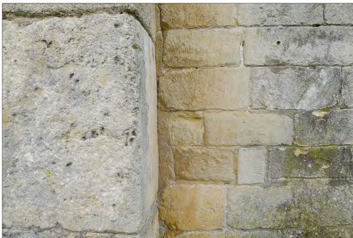
Fig. 6. Sillería pórtico, muro occidental. Empleo de calizas margosas, lugar donde ha sido seleccionada la muestra E1
