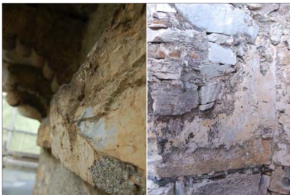
Fig. 4. Restos conservados de revoco originario bajo la cornisa tramo oriental aula y sobre el contrafuerte oeste fachada meridional
