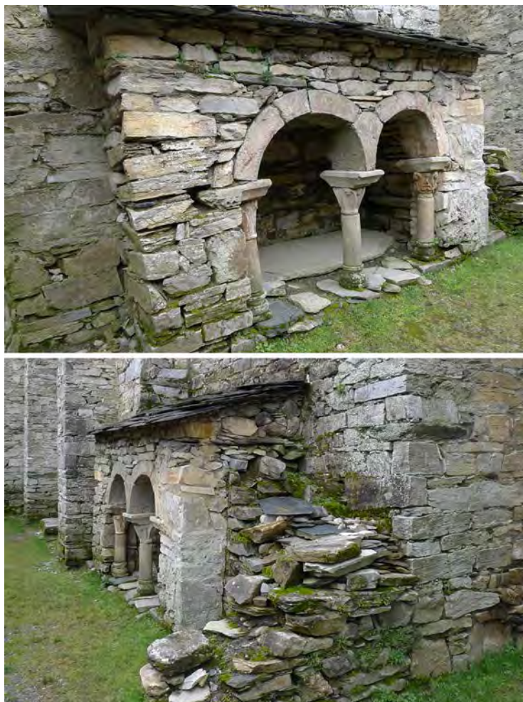
Fig. 23. Cenotafio adosado a la fachada norte del ábside occidental
