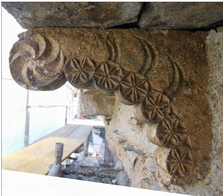
Fig. 15. Modillón polilobulado del alero del tramo oriental aula en el que se reconocen todas sus características pero que corresponde a la fase 2 (A124, UE1073: Modillón número 11)
