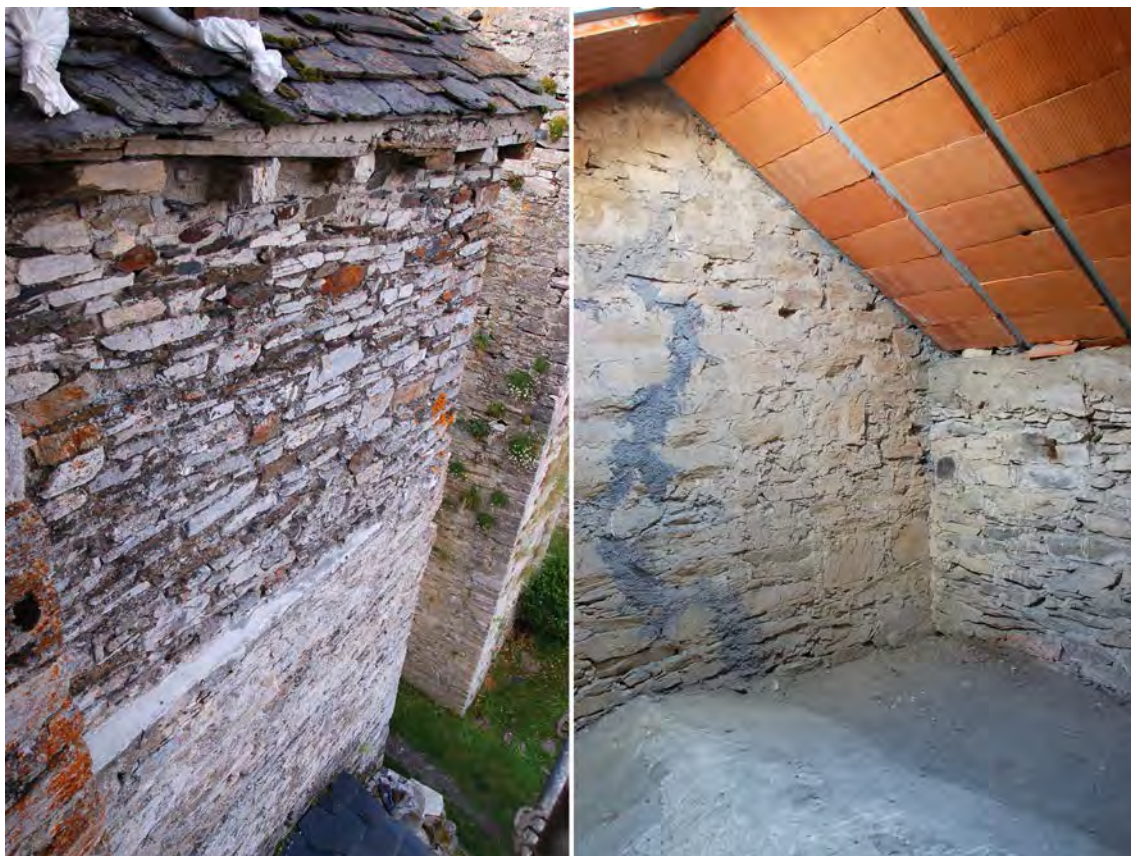
Fig. 22. Fachada septentrional y espacio interior adosado sobre el tramo occidental del aula de la cámara recrecida sobre el ábside occidental
