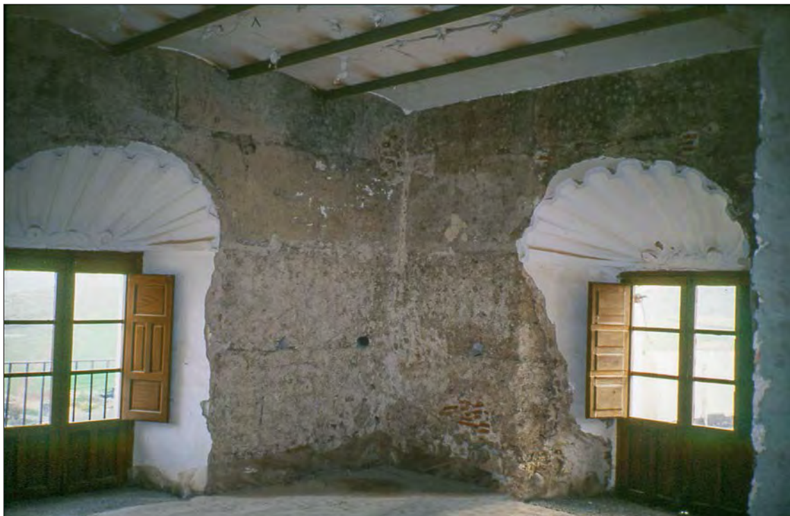
Lám. 5. Caras norte y este del interior de la estancia moderna de la Torre del Aire. Obsérvese el cambio de textura en las tapias a la altura de la base de las veneras, así como los orificios dejados por la desaparición de los elementos lignarios.
