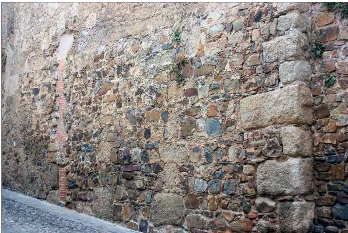
Lám. 19. Cara intramuros del lienzo comprendido entre la Torre de los Púlpitos y el Arco de la Estrella.
