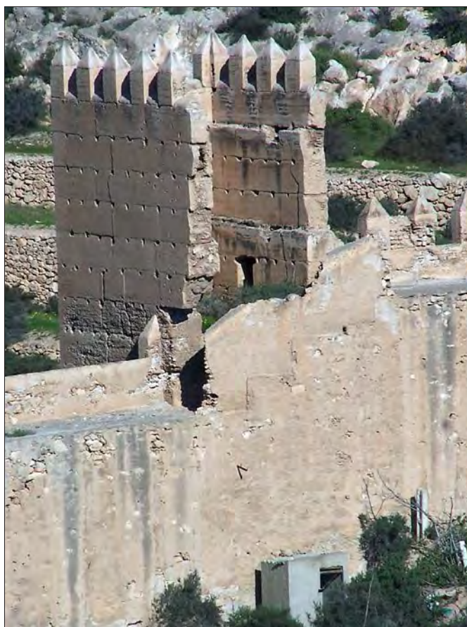
Lám. 8. Torre de la Muralla de la Hoya, en Almería. Gracias a la rotura del paramento que mira a intramuros, se puede apreciar el escalonamiento en el que se alojaban los dos forjados de la torre, y los huecos dejados por la desaparición de las respectivas vigas maestras.
