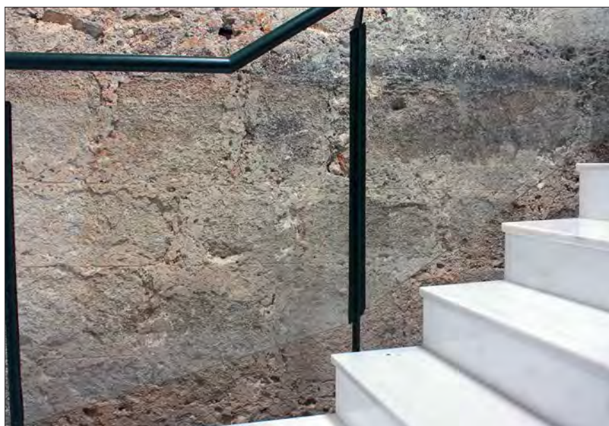
Lám. 12. Detalle del paramento pétreo visible desde el interior del inmueble de la calle Hornos. Destaca la presencia de los dos tipos referidos de líneas incisas sobre el mortero de las juntas de los sillares.
