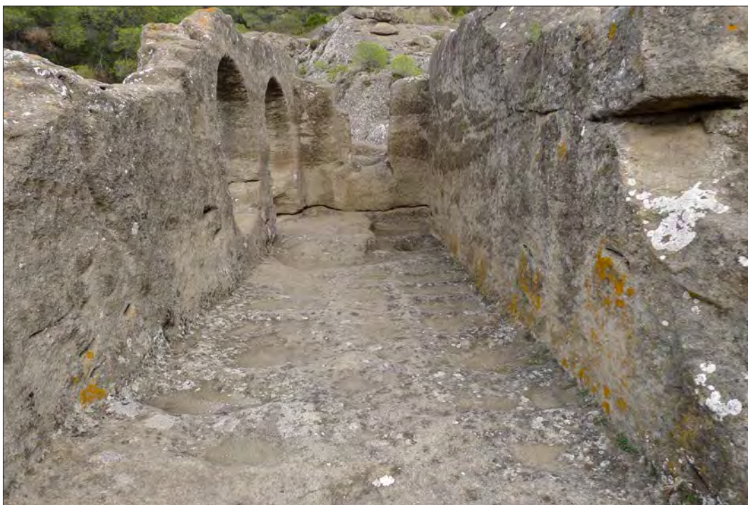
Fig. 8. Huellas de labra en las paredes y suelo (improntas de los sillares) de la nave sur de la iglesia semirrupestre de Las Mesas de Villaverde
