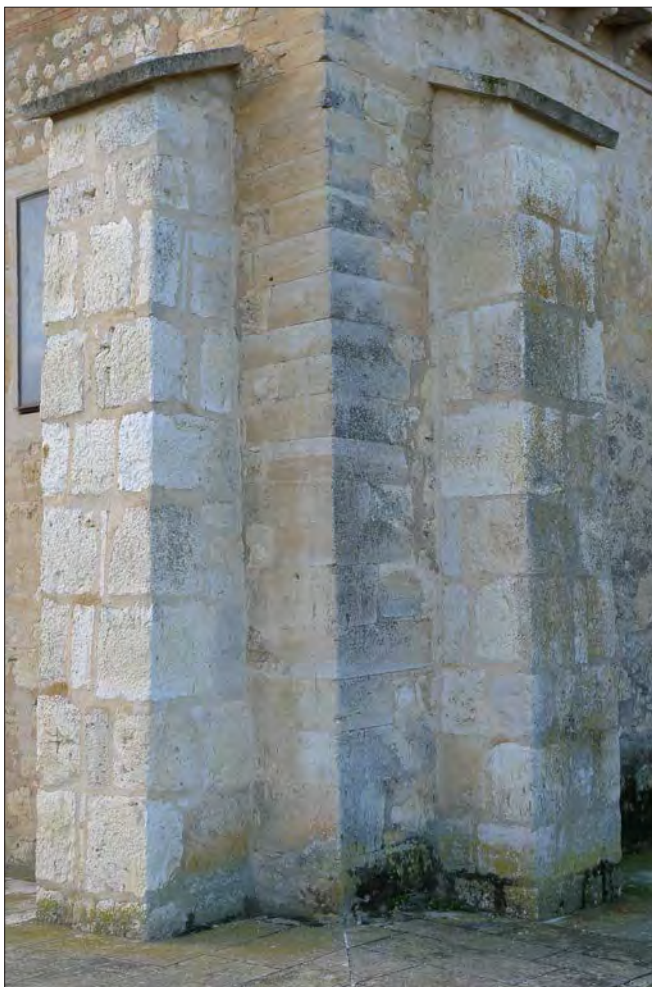
Fig. 3. Detalle de la esquina del ábside norte de San Cebrián de Mazote
