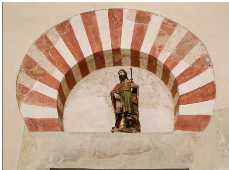
Fig. 6. Arco estucado del muro septentrional de la nave transversal de San Cebrián de Mazote
