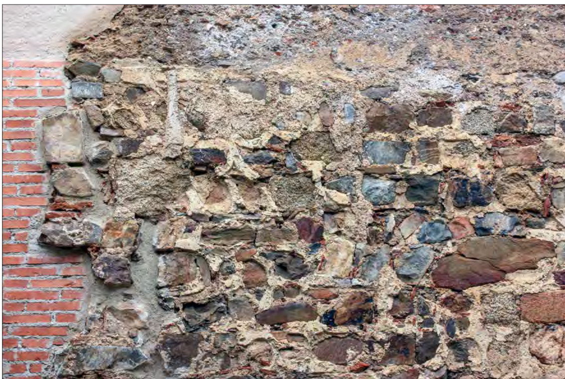
Lám. 20. Detalle del lienzo intramuros, en el que se aprecian las cintas de mortero de cal que ciñen los mampuestos, y la cinta horizontal que marca el límite con la hilada de tapia que se aprecia por encima.
