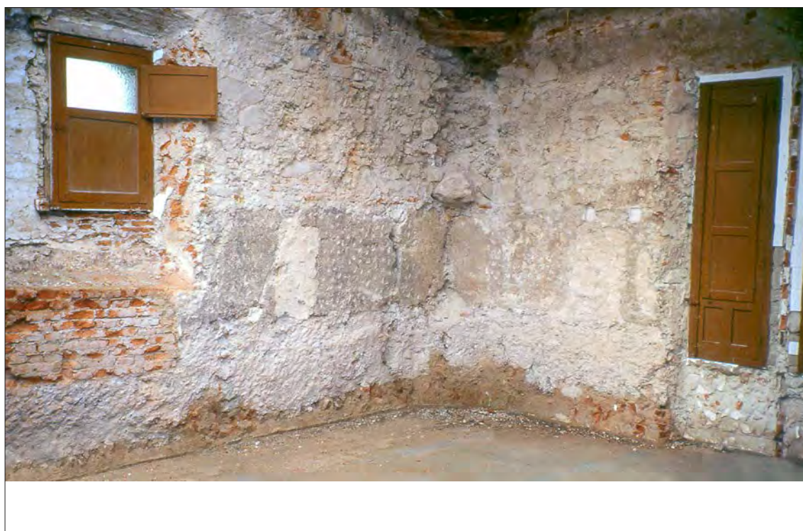
Lám. 6. Caras norte y este del interior de la estancia cimera de la Torre del Aire. Obsérvense los restos del pretil con las saeteras cegadas.
