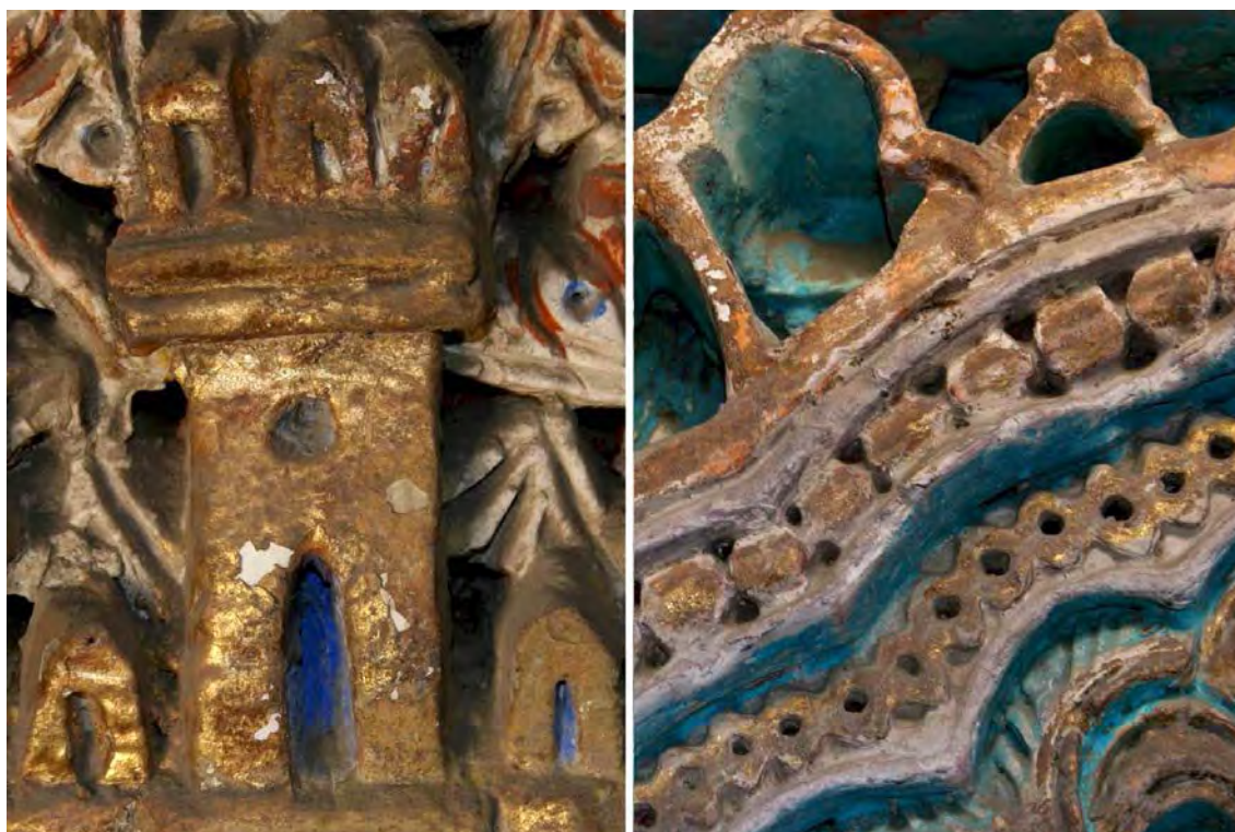
Fig. 25. Imágenes de detalle de la superficie de las yeserías en las que se conservan restos de dorado de la última intervención.
