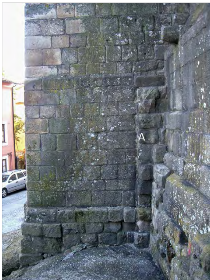
Fig. 13. Sé de Viseu. Cunhal (ou contraforte) pré-românico (?) incorporado na junção da fachada setentrional da torre Sudeste e o maciço nascente da Sé. Com a letra A identifica-se o silhar que foi afeiçoado para formar o ângulo de 90°
