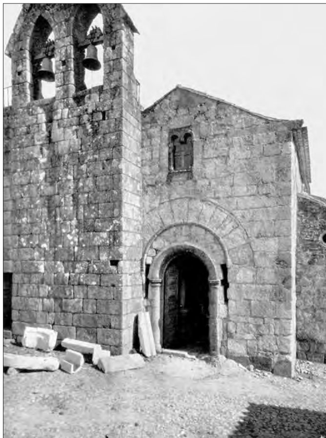
Fig. 26. São Pedro de Lourosa. Fachada principal da igreja aquando do início do restauro (sondagens parietais para definir a forma do arco pré-românico de acesso ao narthex ). No segundo piso, observa-se um já fragmentado ajimez, suprimido durante o restauro. Foto Marques Abreu
