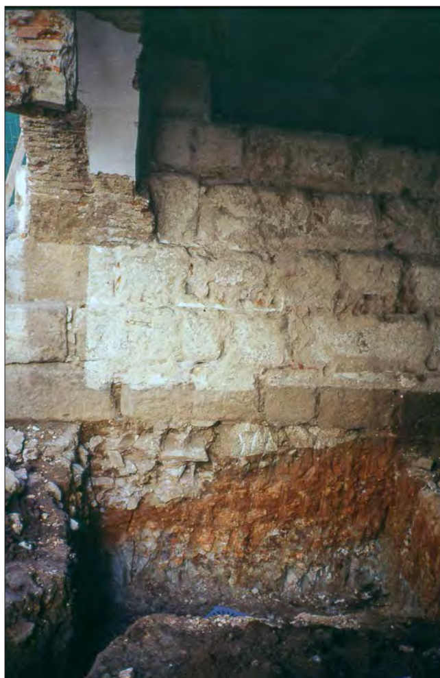
Lám. 2. Cara septentrional de la base de la torrecilla. En la parte izquierda se aprecia la escasa cimentación, que incluso llega a desaparecer en la parte derecha, según va elevándose el contorno del nivel geológico.
