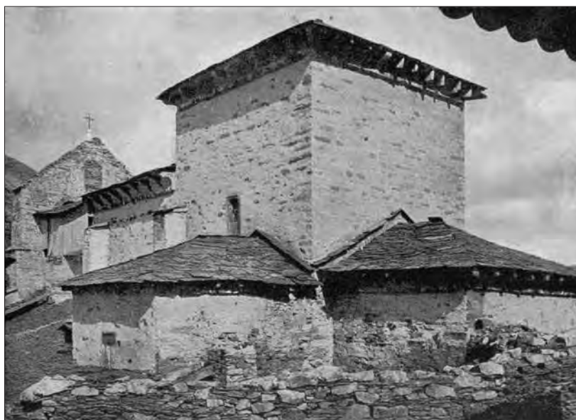
Fig. 26. Vistas del exterior de la iglesia desde sur-este donde se puede observar la mampostería de sus muros parcialmente cubierta por el acabado original y sus sucesivas reparaciones (GÓMEZ-MORENO, 1925: Fig. 46)
