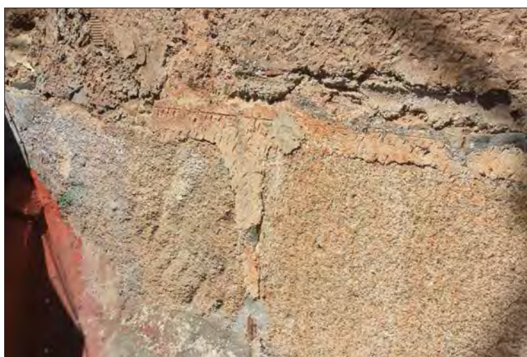
Lám. 11. Detalle de la hilada de sillares de la cara oriental de la Torre Redonda, en el inicio del prisma octogonal. Se aprecian las líneas trazadas sobre los restos del mortero original, tanto las que simulan un aparejo regular como las incisiones cortas en diagonal.
