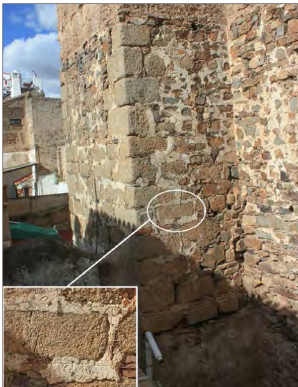
Lám. 13. Cara sur de la torrecilla sita entre las torres del Postigo y Aver, con detalle del mencionado remate epidérmico.
