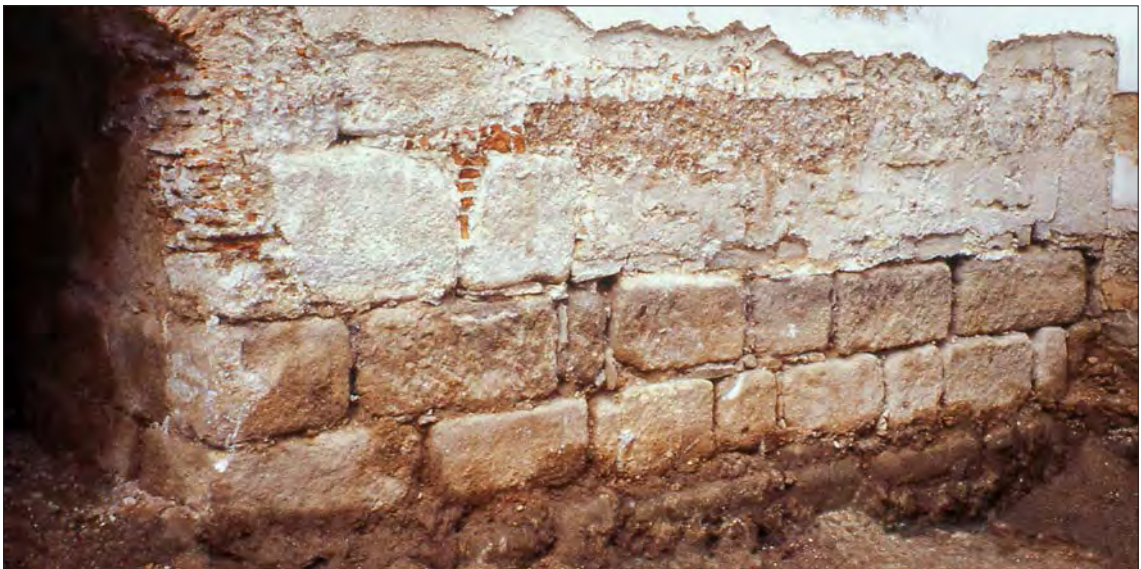
Lám. 4. Vista oriental de las hiladas de sillares en la base de la albarrana.
