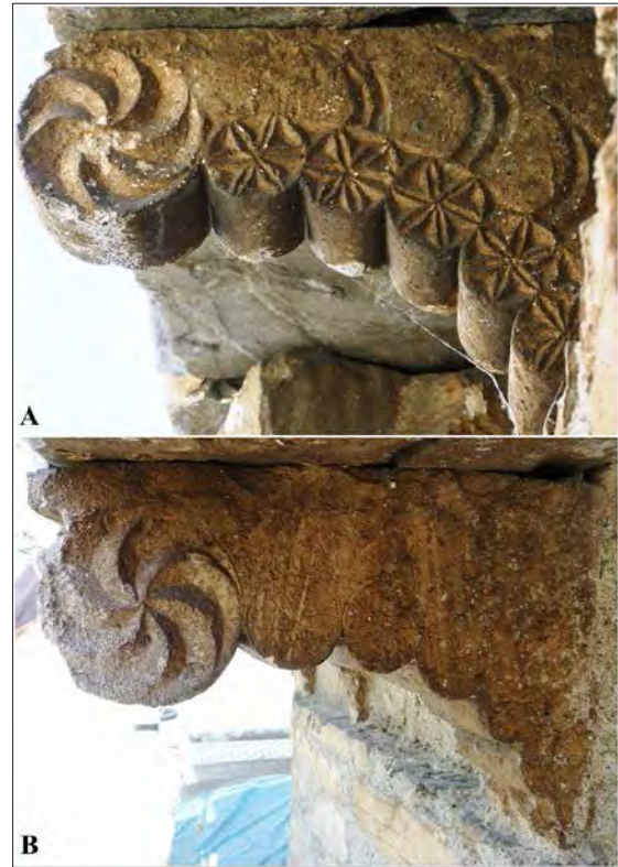
Fig. 13. Santiago de Peñalba. Modillones del alero del cuerpo central. Ejemplares terminados (A) e inacabados (B).
