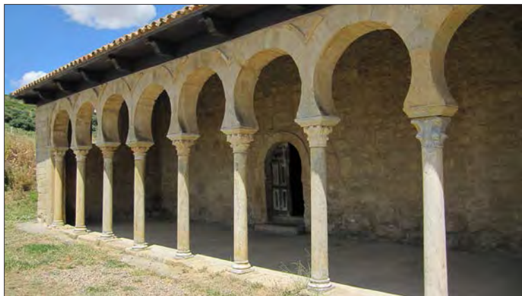
Fig. 16. San Miguel de Escalada. Pórtico S, sector occidental (obra del siglo X).
