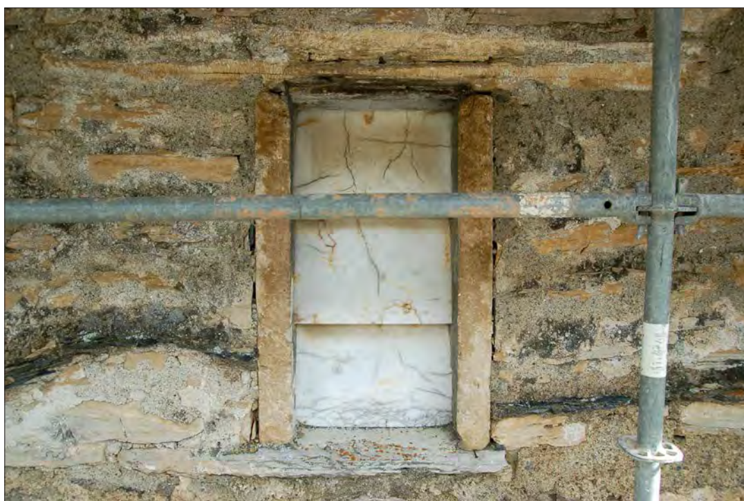
Fig. 6. Ventana de la fachada meridional del tramo occidental del aula
