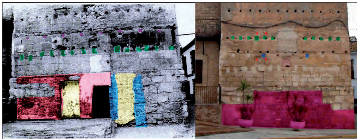
Fig. 8. A la izquierda, diferentes afecciones contemporáneas sobre el basamento pétreo de la torre, realizadas por las viviendas adosadas del siglo XX. Vanos, cerchas y cubiertas se representan en diversos colores. A la derecha, en color rosa, sillería de restauración del año 2000. (Montaje propio de los autores sobre fotografías contenidas en LÓPEZ GARCÍA, 2018).
