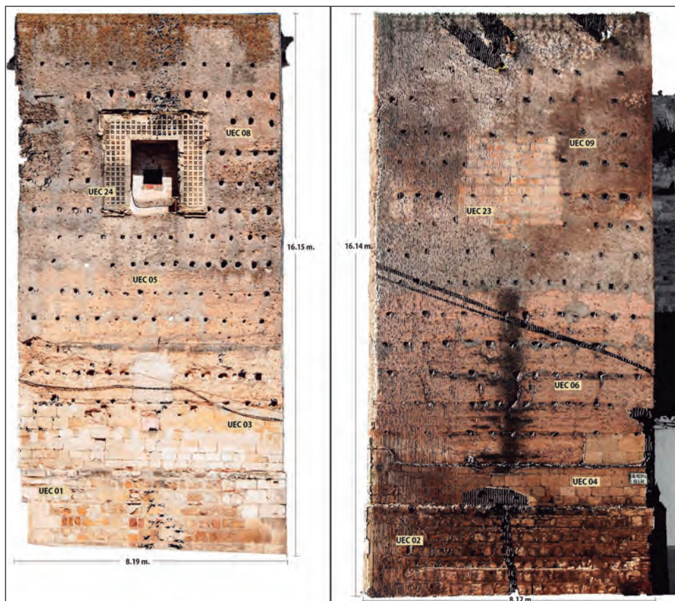
Fig. 3. Alzados de las fachadas sur y este de la torre sureste con las unidades constructivas correspondientes y sus dimensiones. (Elaboración propia de los autores).
