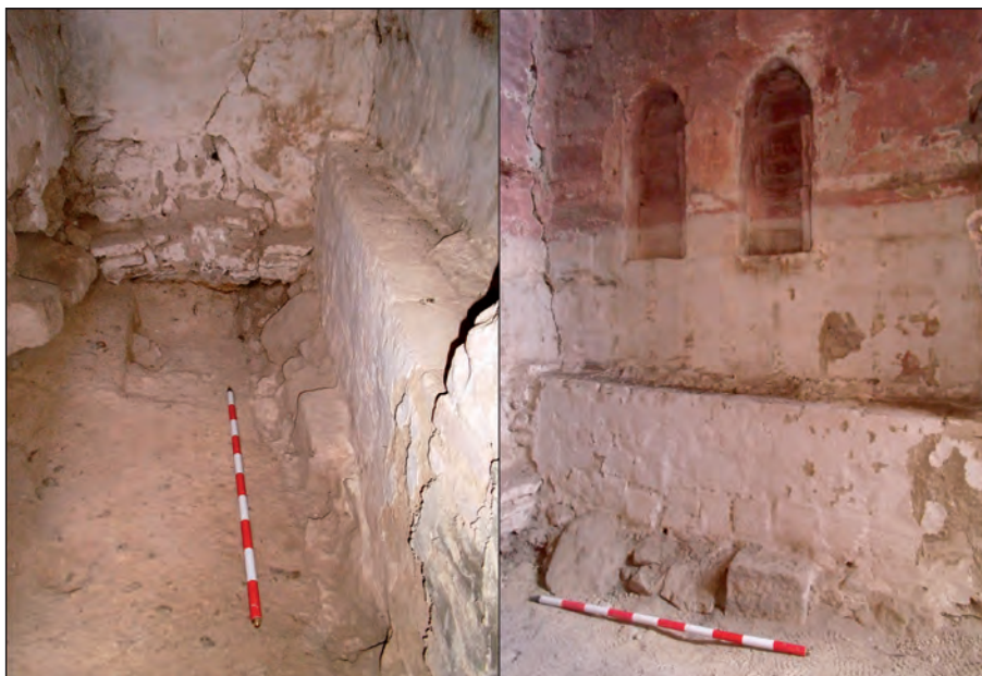
Fig. 13. Relaciones del forro de sillarejos y paramento oeste cortando la tapia tar-doislámica (izda.). Forro de sillarejos, rebanco y paramento oeste con doble ventana (dcha.). (RODERO, 2015).
