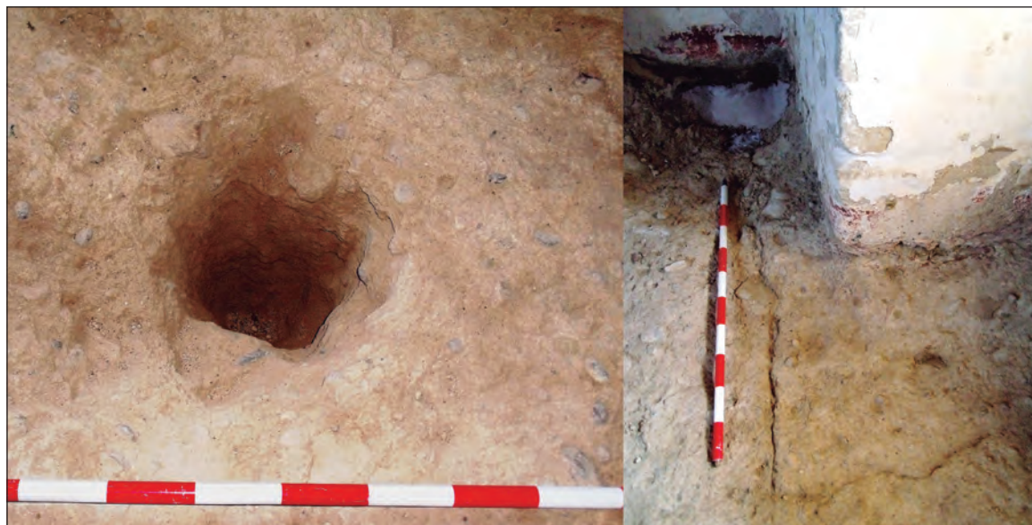
Fig. 10. A la izquierda detalle de uno de los postes de arriostrado de las cajas de tapial. En la derecha el contacto entre hilos de cajas de tapial en el suelo de la cámara. (RODERO, 2015).
