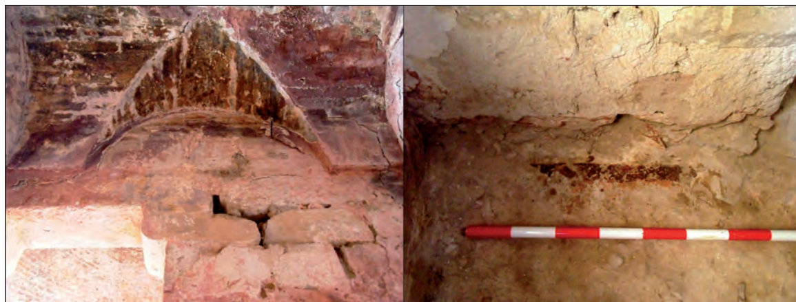
Fig. 17. Detalle de la bóveda de arista de la estancia menor apoyando sobre muro medianero de sillarejos (izda.). Detalle decorativo sobre el tapial tardoislámico a modo de “cinta de almagra” que definen el suelo original de la estancia (dcha.). (RODERO, 2015).
