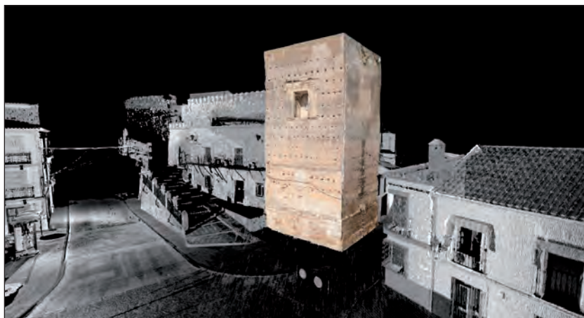
Fig. 2. Torre sureste del castillo de Santaella (Córdoba) a partir del Escáner Laser Digital. (Elaboración propia de los autores).
