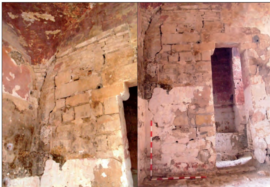
Fig. 14. Muro medianero de sillarejos escuadrados cortando la tapia tardoislámica, rota también por la bóveda baída de ladrillos. (RODERO, 2015).
