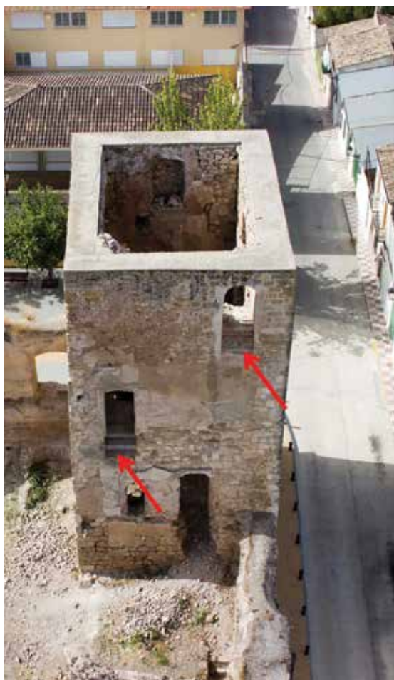
Fig. 11 La torre con escalones en los vanos de la cara norte. El acceso inferior es la puerta de la torre a la 1ª planta, sobre el aljibe (dentro), situada sobre la cripta-oratorio (fuera).
