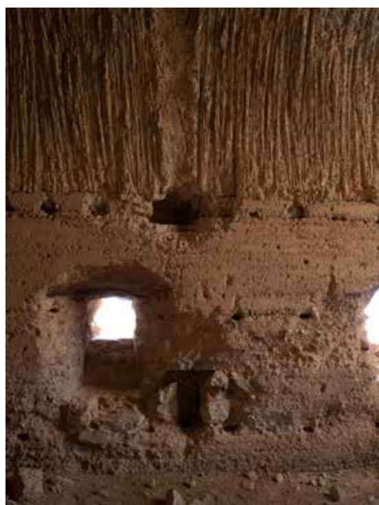
Fig. 11. Muro sur de la torre desde el interior. En la parte inferior, aspillera modificada en fase IV. En la parte superior huellas de la cimbra en la bóveda.
