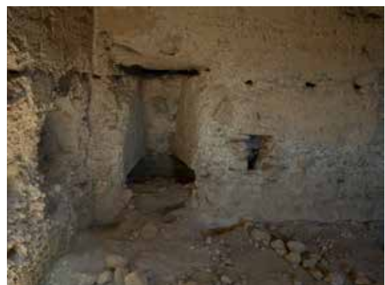
Fig. 15. Vista de aspillera cegada en fase II y umbral eliminado posteriormente.
