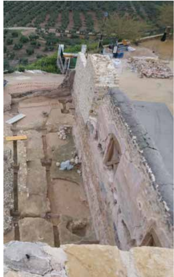
Fig. 17a Planta baja de la crujía interior del lado sur. Se aprecia el hueco para una gran tinaja
