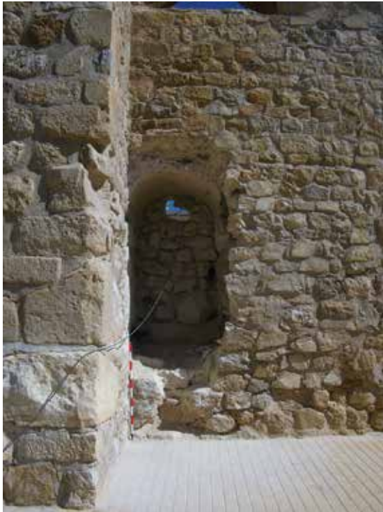
Fig. 16 Comunicación entre las dos crujías del lado sur con bóveda de medio cañón.
