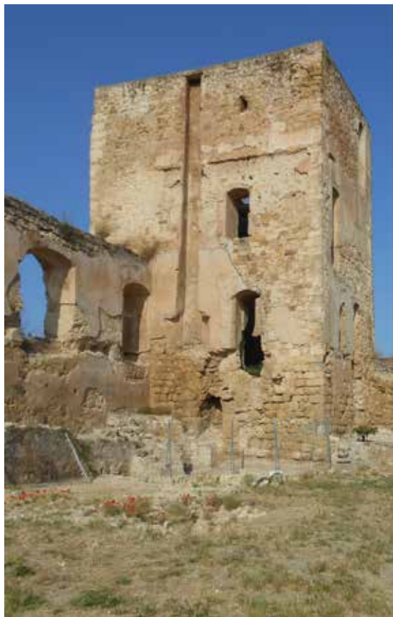
Fig. 19 Lado este de la torre y muro sur. En este último se aprecian dos de los vanos que comunicarían las crujías. En la primera, la chimenea, y vanos de acceso a las plantas 2ª y 3ª de la torre
