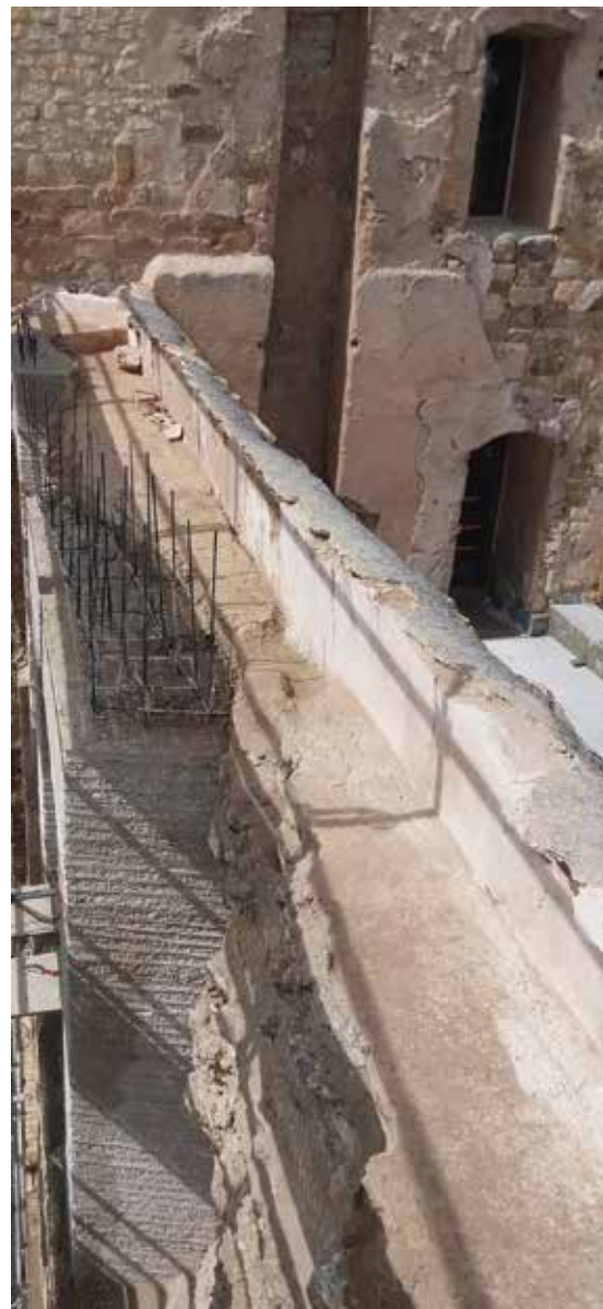
Fig. 20 Adarve desde la torre. El pretil, que fue cubierto de cemento en la restauración del año 1987
