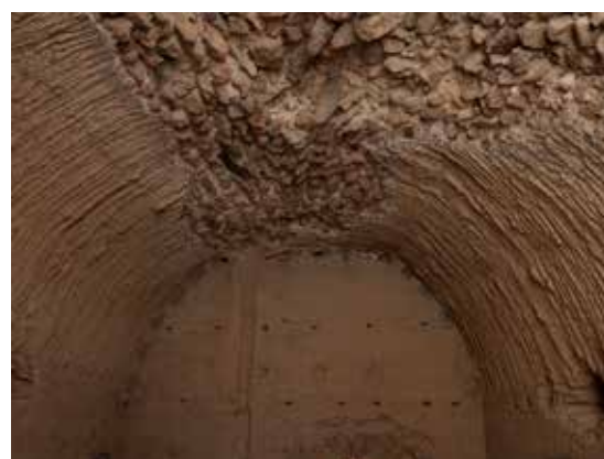
Fig. 12. Deterioro en la clave de la bóveda y detalle de fábrica.
