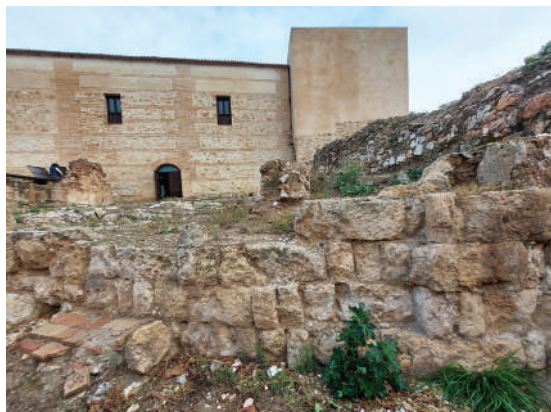
Fig. 8. Exterior del muro sur (soga y tizón) del edificio emiral-califal del patio de armas de la Alcazaba.
