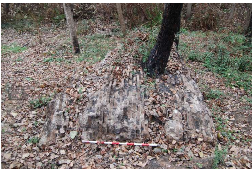
Fig. 8. Tramo central de la presa (E6), volcado y desplazado hacia agua abajo (foto autora)
