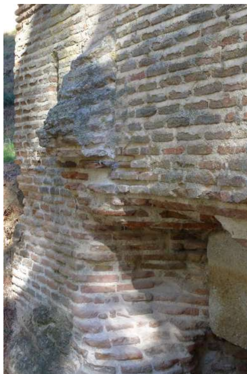
Fig. 16. Contrafuertes tipo arbotante en el frente del cubo B (foto autora)
