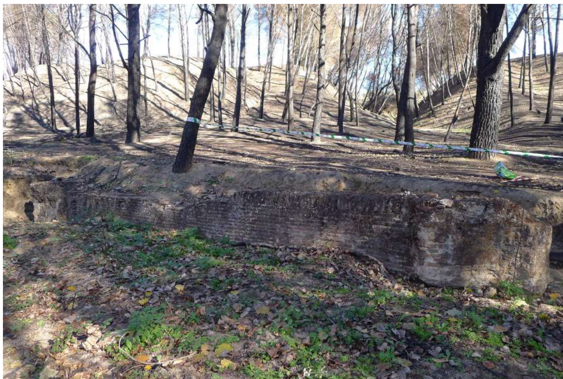
Fig. 17. Alzado oeste del muro E4, con arranques de contrafuertes (foto autora)
