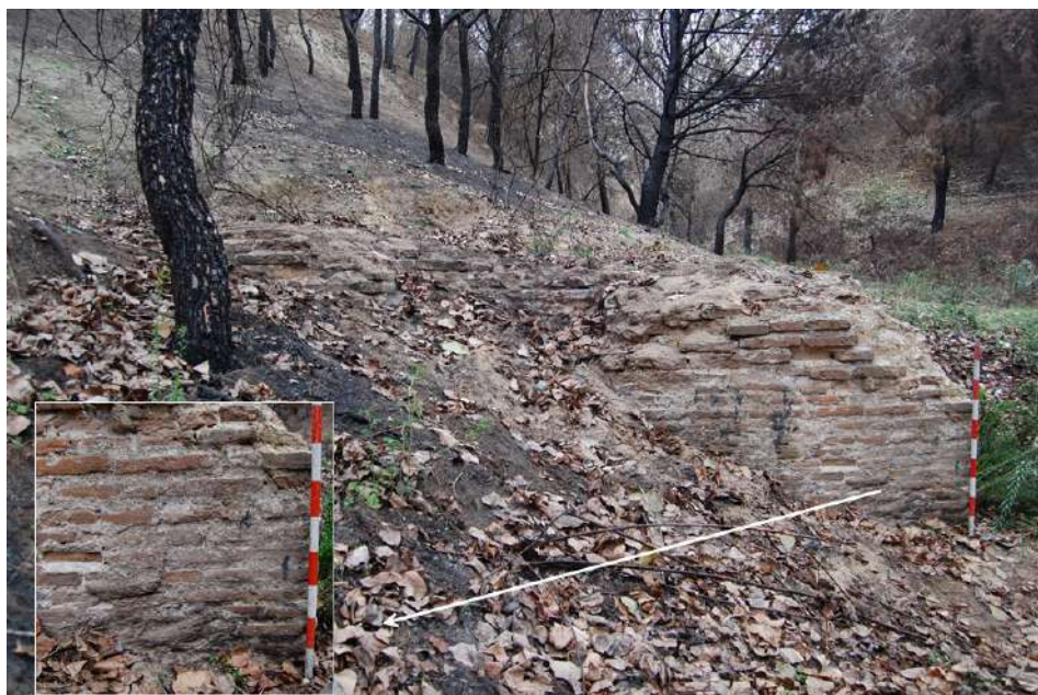
Fig. 10. Alzado de agua abajo del estribo derecho de la presa (E7) y detalle del enfoscado de argamasa de cal que lo recubría (fotos autora)
