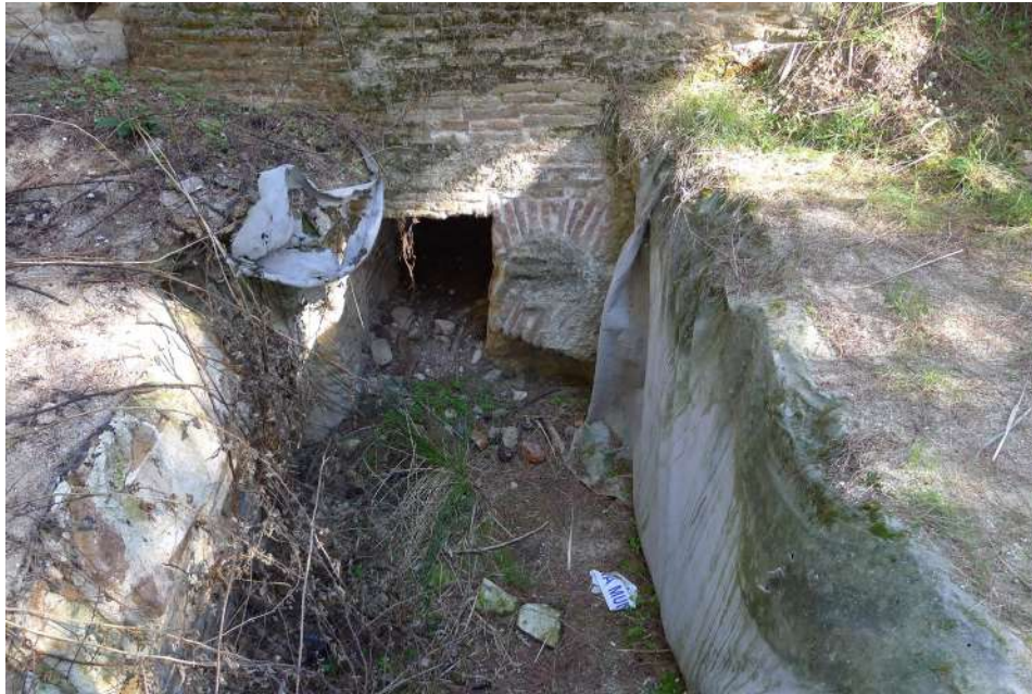
Fig. 12. Salida cegada del saetín original (molino A) y vano abierto en la fase II (foto autora)
