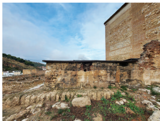
Fig. 7. Interior del muro oeste (soga y tizón) del edificio emiral-califal del patio de armas de la Alcazaba, amortizado por el aljibe nazarí.
