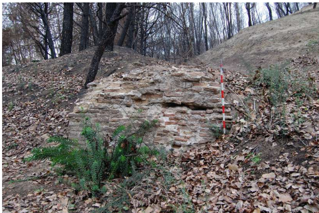
Fig. 9. Vista en sección del estribo derecho de la presa (E7) (foto autora)
