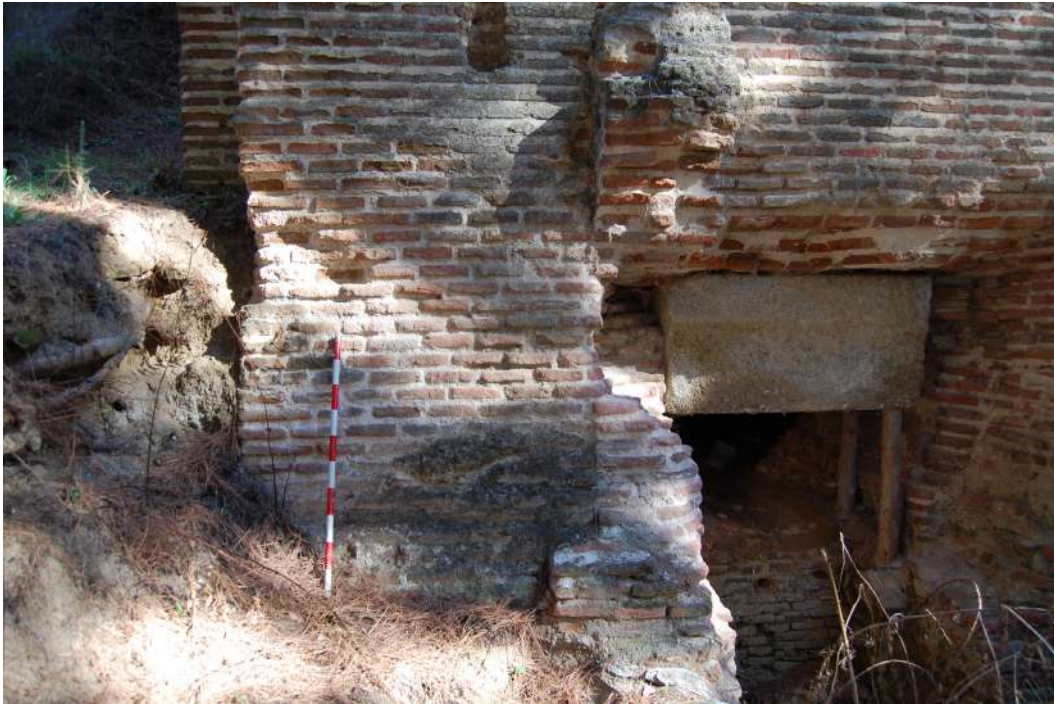
Fig. 21. Cegamiento inferior del saetín con ladrillos en el cubo B (foto autora)
