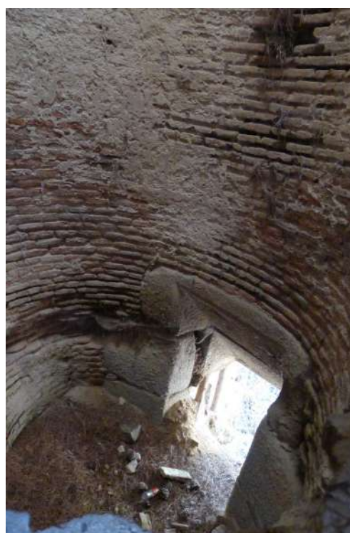
Fig. 15. Vista interior de la salida del saetín en el cubo B (foto autora)
