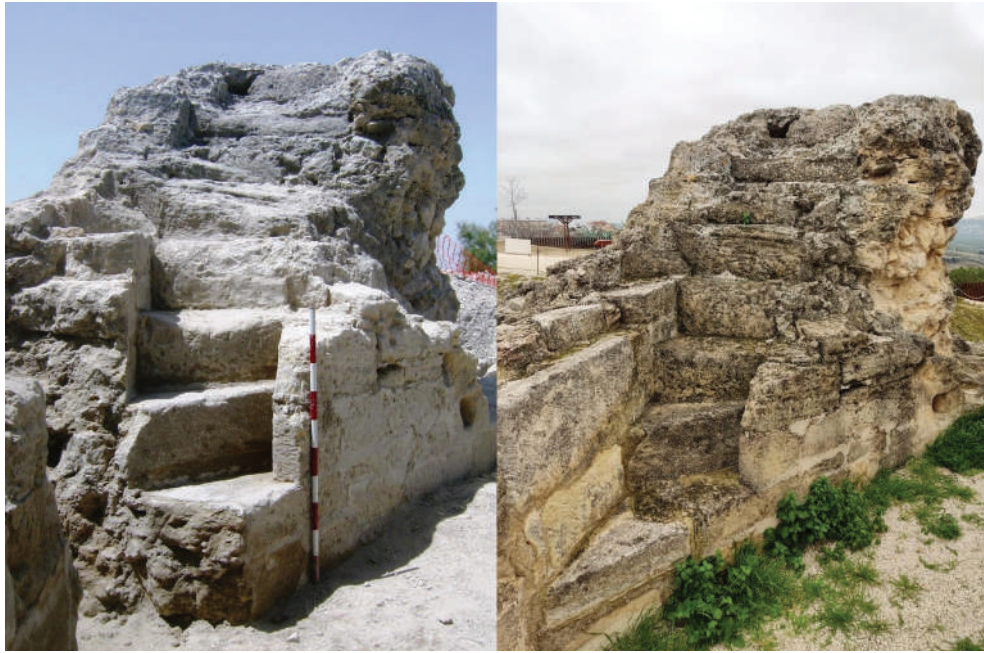
Fig. 8. Escalera de acceso al adarve antes y después de su restauración. Se observan con claridad los seis peldaños a modo de caracol en dirección sur-oeste, que aún se conservan. Foto: C. Carbajo.
