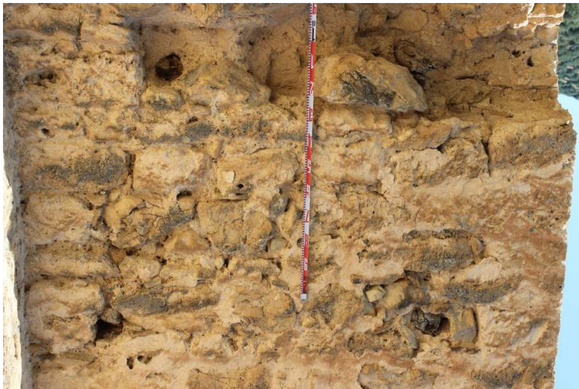
Fig. 8. Imagen del machón sur y agujas de madera.
