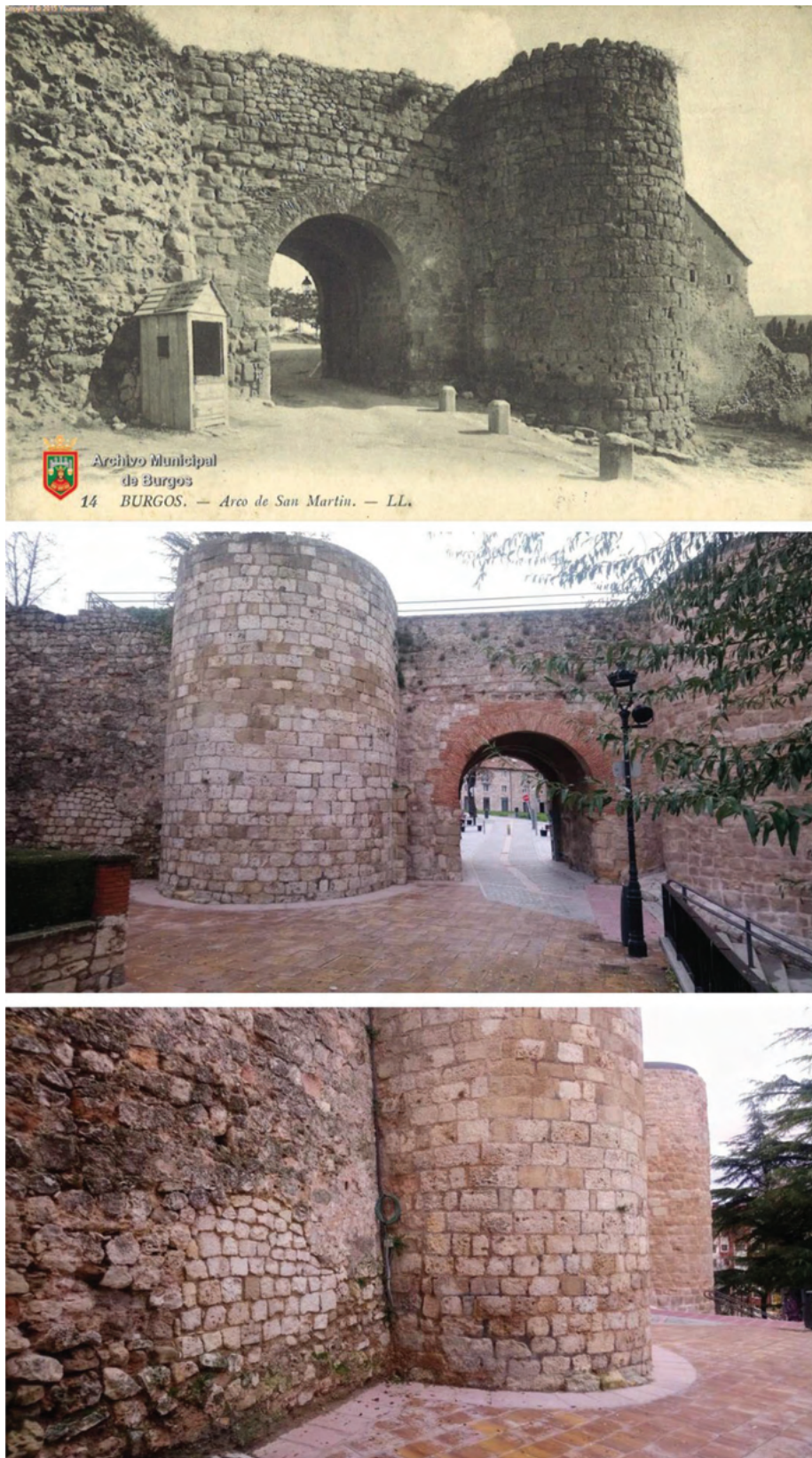
Figura 5. (Sup.) Fotografía antigua del arco de San Martín. Archivo Municipal de Burgos, FO -28429. Nótese el cubo norte con el ripio interior a la vista y la sillería exterior expoliada. (Centro) Arco de San Martín extramuros. (Inf.) Encuentro del cubo norte con el lienzo de la muralla donde se realizó la excavación arqueológica.
