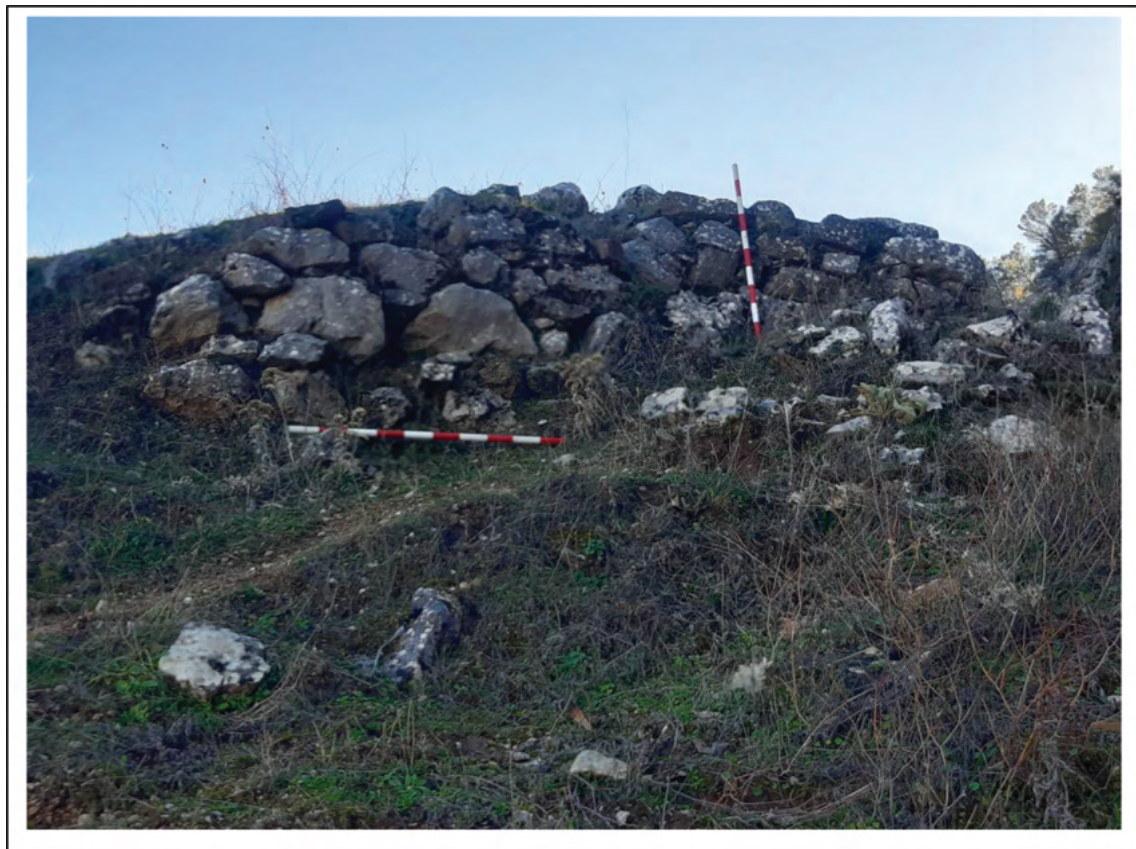
Figura 14. Muro de cierre de la alquería de Peñaloja.
