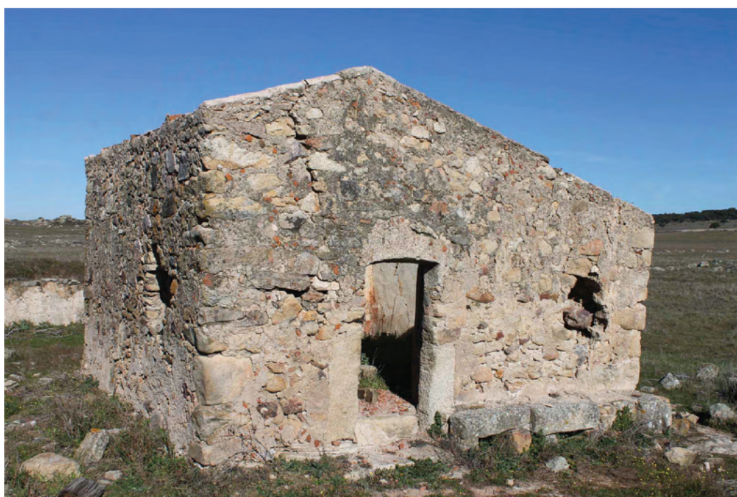
Figura 11. Casa 2 (desde el sur).
