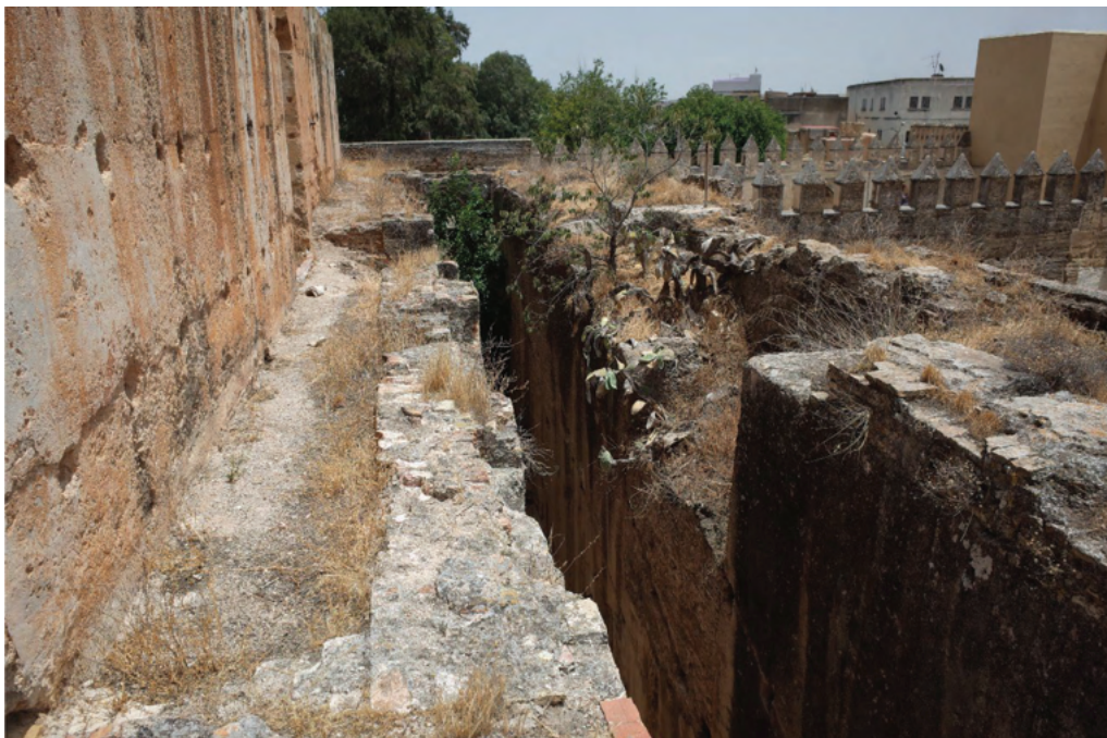
Figura 8. Gran noria de al-Mușāra en Fez la Nueva. Vista de la coronación de la caja con restos de pilares arrasados.
