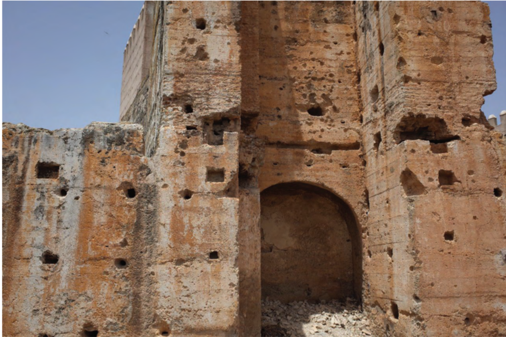
Figura 7. Gran noria de al-Mușāra en Fez la Nueva. Vista del machón sobre la coronación de la caja.
