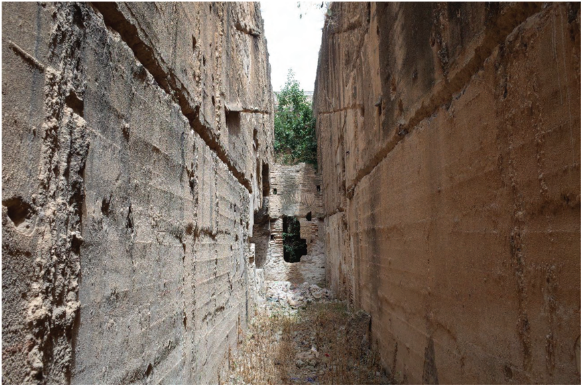
Figura 5. Gran noria de al-Mušāra en Fez la Nueva. Vista interior del canal.
