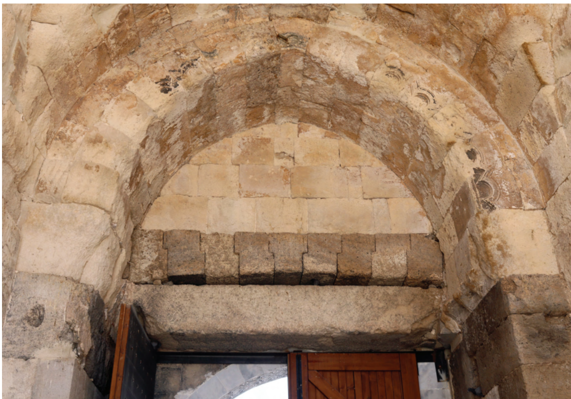
Figura 24. Detalle de la faz interior del vano de acceso de la portada exterior del caravasar de Sultanhanı (© Los autores).
