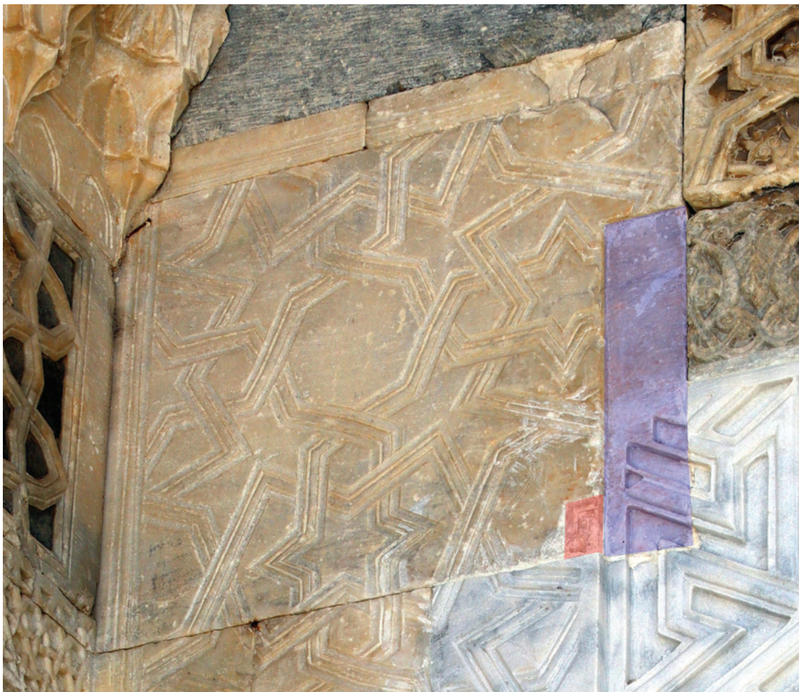
Figura 21. Detalle del vano de acceso de la portada exterior del caravasar de Sultanhanı: Sillar A18, de 1229; con la esquina del marco original de la banda de lacería, indicada en rojo; y con el rebaje de 1278, indicado en violeta (© Los autores).
