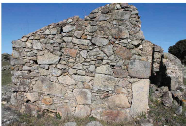
Figura 24. Casa 1. Detalle del paramento junto a la puerta.
