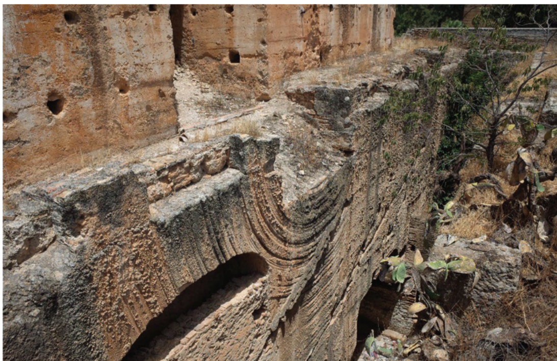
Figura 11. Gran noria de al-Muṣāra en Fez la Nueva. Cajeadado para el apoyo de la rueda y huellas de rotación.
