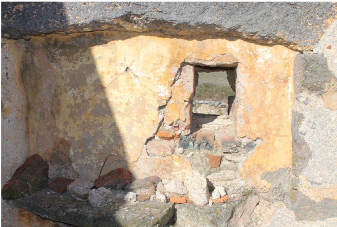
Figura 15. Casa 2. Ventana moderna (desde el interior).
