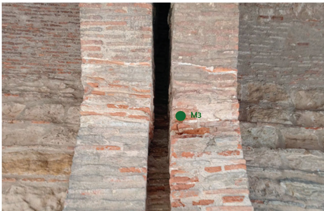
Figura 8. Lugar de procedencia de los morteros de cal analizados de los distintos cuerpos de fábrica: base de cimentación del cubo norte (M1), estructura cuadrangular adosada (M2) e intradós del arco central (M3).
