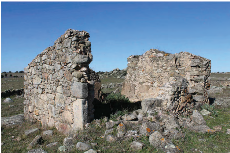
Figura 10. Casa 1. Solo se conservan en parte algunos de los muros.
