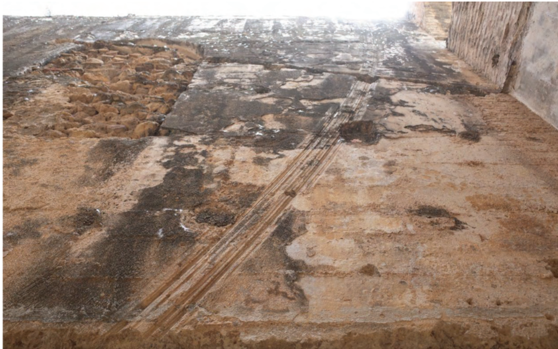
Figura 10. Gran noria de al-Muṣāra en Fez la Nueva. Paramento interior del canal de la noria con huellas de rotación.
