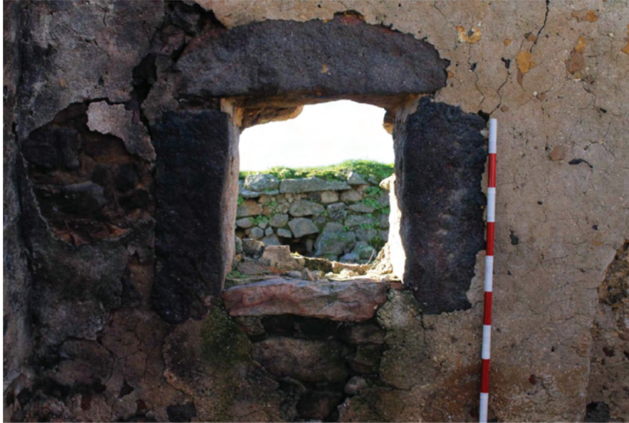
Figura 12. Casa 2. Ventana oeste (desde el interior).
