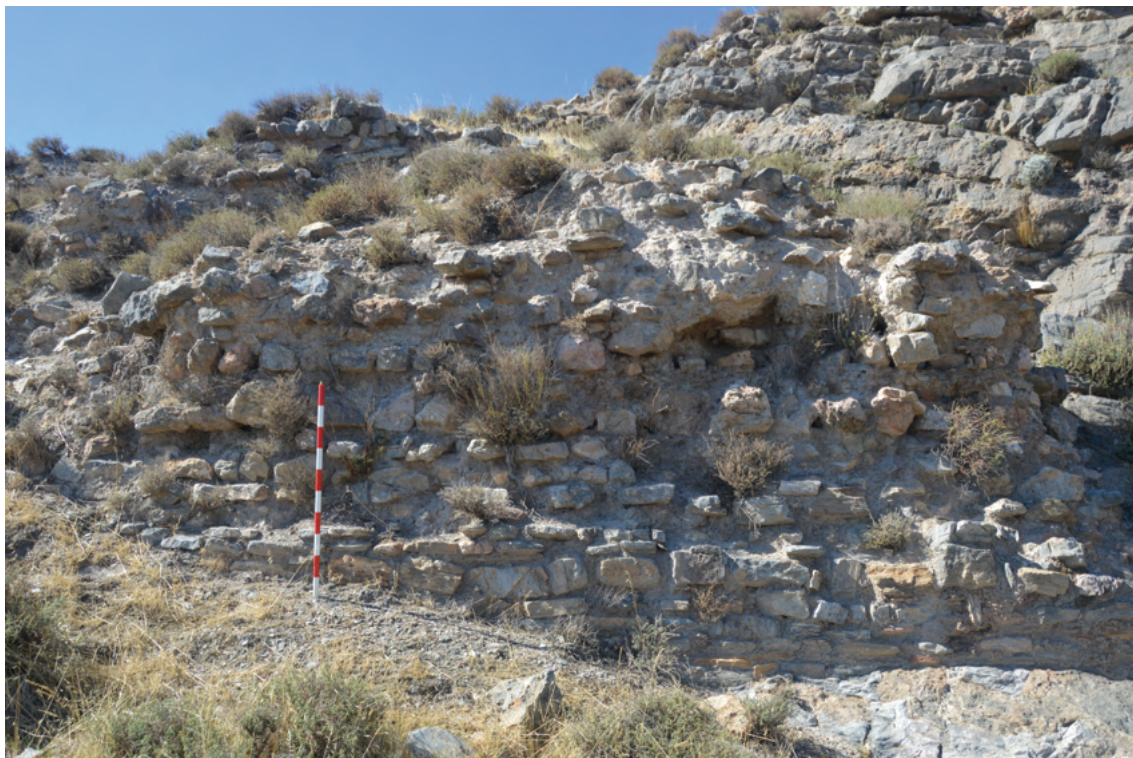
Figura 10. Torre de tapial de calicanto del recinto superior (UEs 13 y 33).
