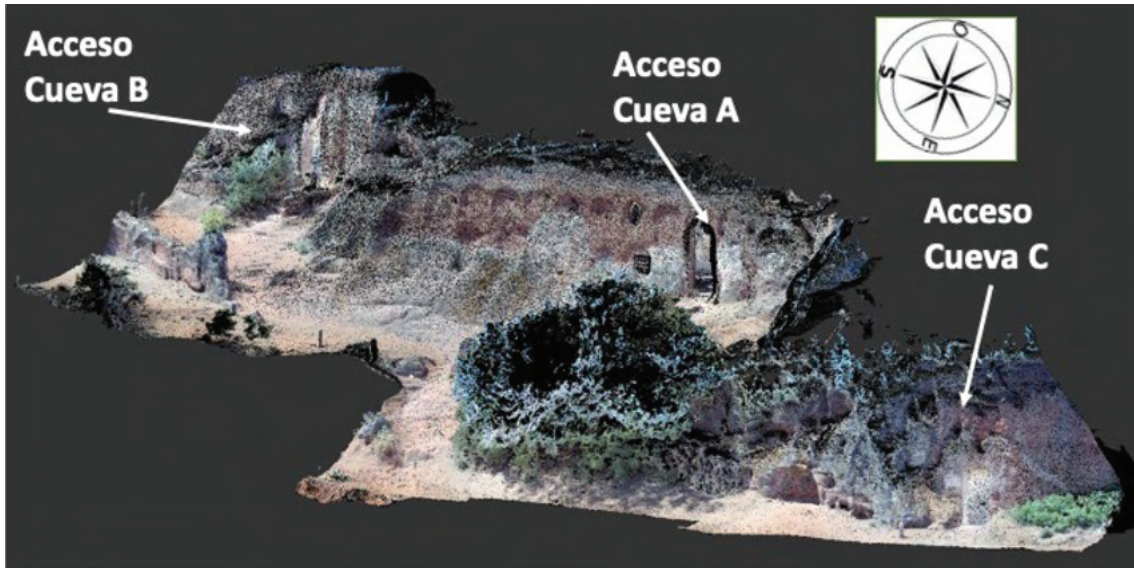
Figura 12. Vista general del ERV desde el nordeste.
