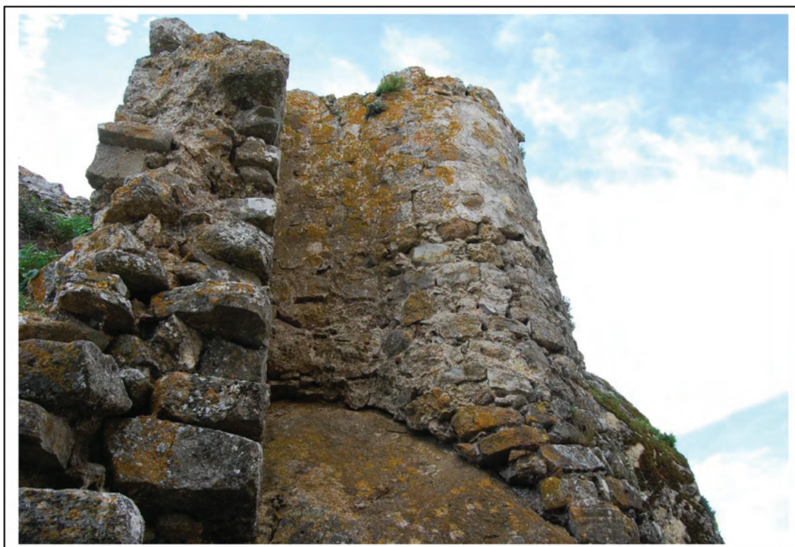
Figura 3. Torre ultrasemicircular y muro de cierre en el acceso a la fortaleza.
