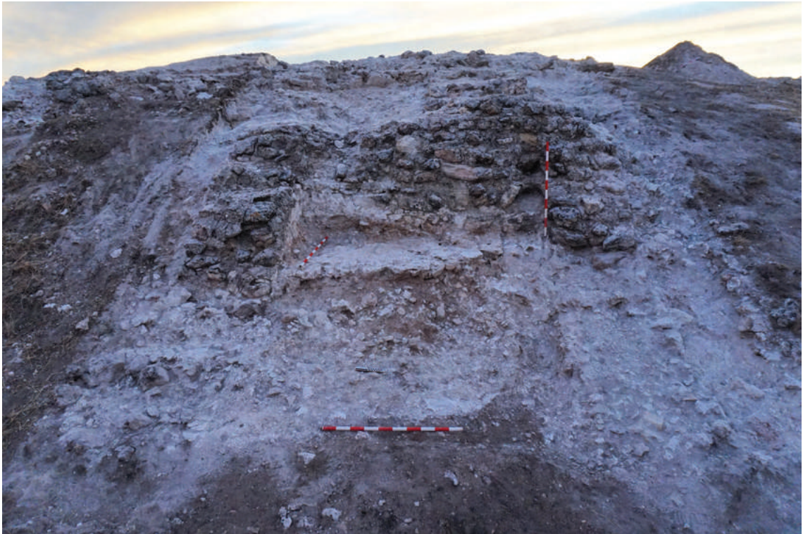
Figura 4. Vista de la Torre 2, donde se aprecia el sistema constructivo del conjunto.
