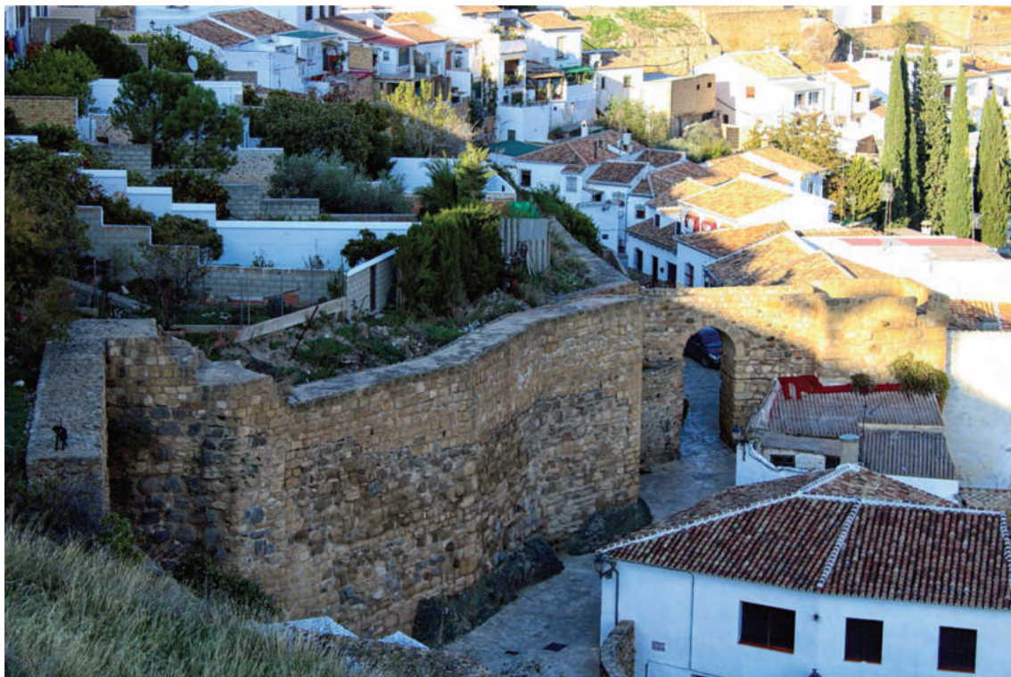
Figura 6. Puerta del Agua. Coracha de Antequera. Fuente: imagen elaboración propia.
