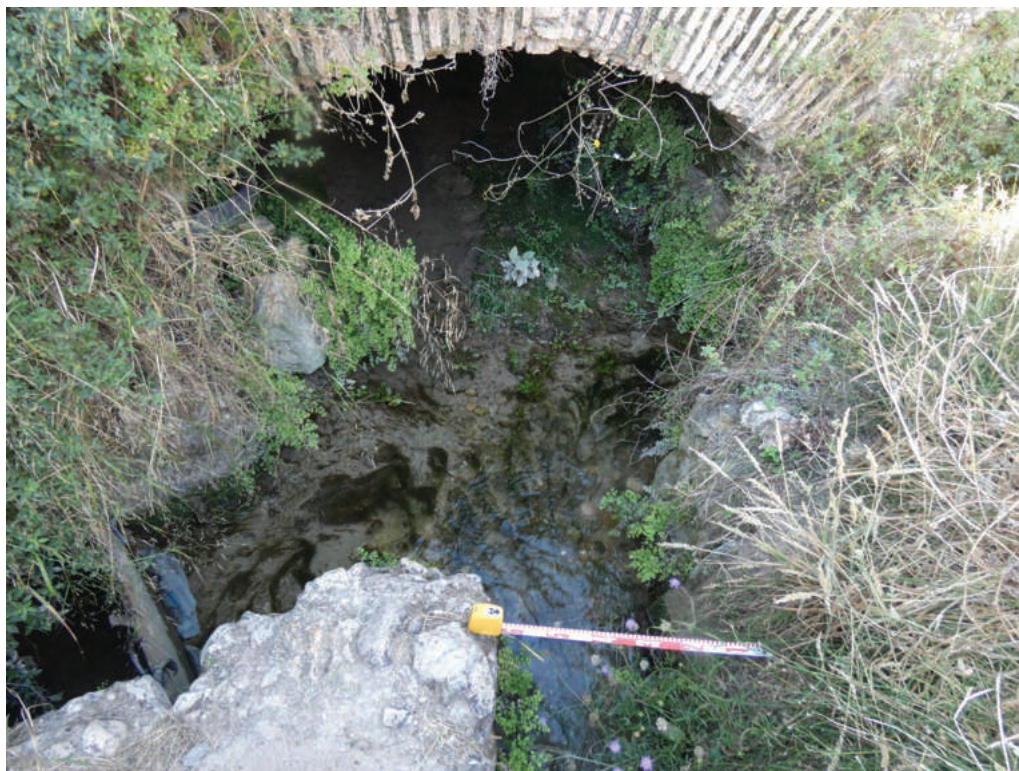
Figura 4. Partidor de aguas proporcional en L'Alba (Ontinyent). Fotografía del autor.
