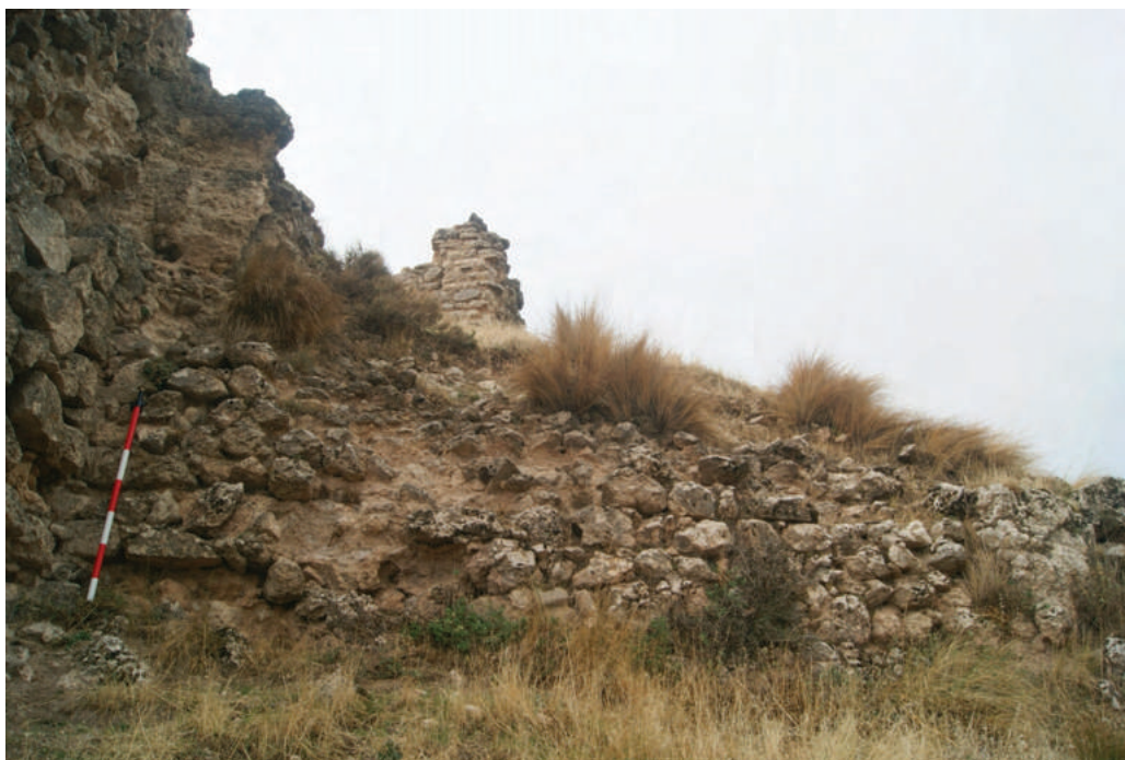
Figura 15. Tramo de muralla exterior noreste (CE 007). Fuente: los autores.
