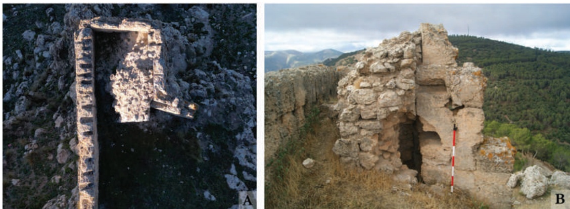
Figura 22. A) Imagen aérea de torre oeste y relleno de mampostería (UE 012); B) Alzado de contacto entre relleno de mampostería y estructuras en tapial. Fuente: los autores.
