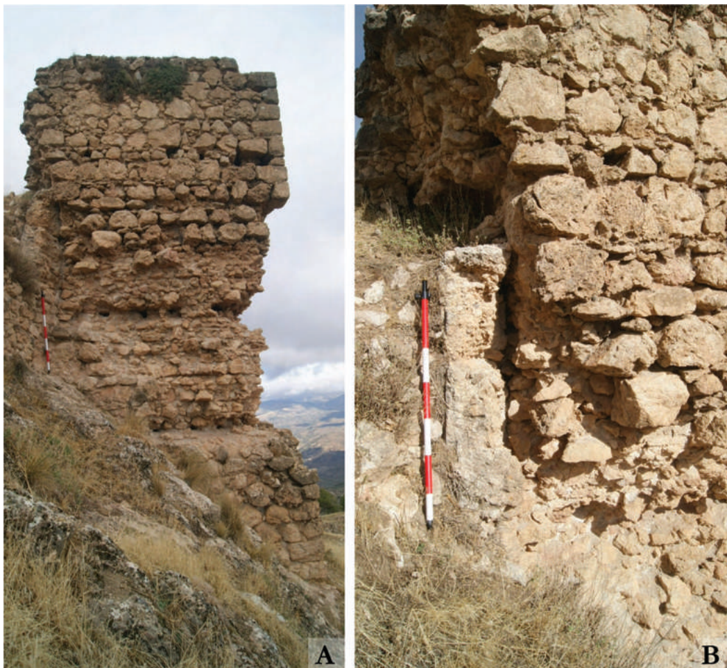
Figura 14. A) Cara sur de torre este-CE 006 en la que se observa el núcleo de la mampostería y la cara externa con los mechinales del andamiaje; B) Alzado en tapial hormigonado sobre el que se adosa la torre este-CE 006. Fuente: los autores.
