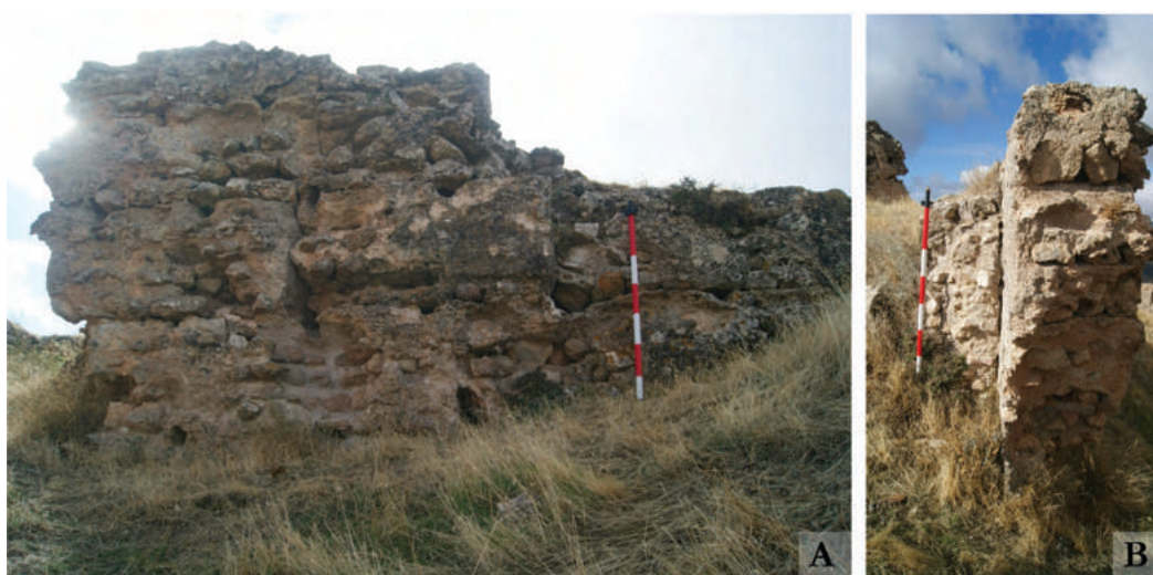
Figura 3. A) Muralla norte en tapial de cal y canto (UE 079); B) Muro de mampostería con arranque abovedado (UE 080) apoyado sobre cara interior de muralla. Fuente: los autores.
