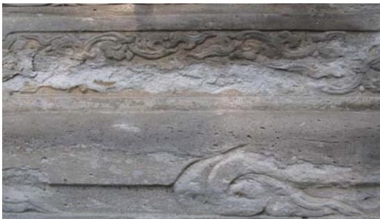
图10碑亭台基：盐性腐蚀及剥离
