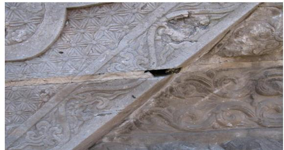
图16 石狮底座：不恰当的水泥沟缝
