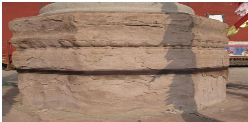
图12大红台前石柱：剥落，裂
