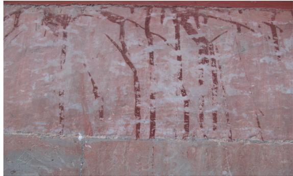
图14碑亭墙：油漆破坏产生污迹，变色
