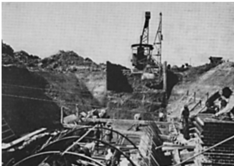
Imagen 8. XIª Sección de la cloaca máxima, conducto desde la desembocadura en el río de la Plata para OSN
