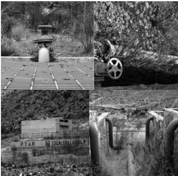
Ilustración 4. Estado actual de la Planta tratadora de Agua de Escalerillas
