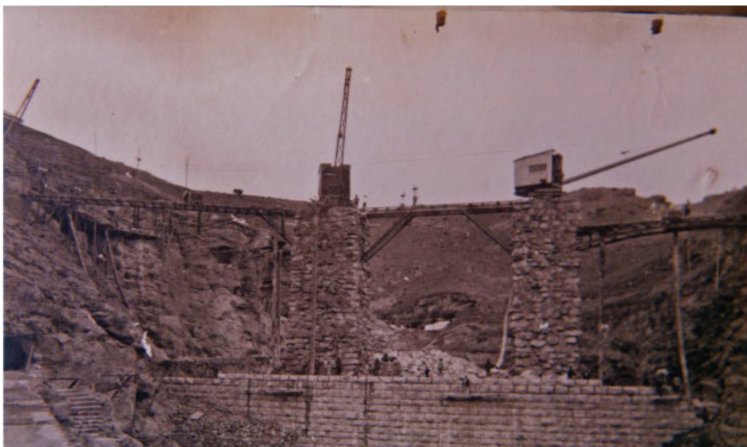
Figura 11. Construcción de la presa del Chorro. Grúas sobre pilares
