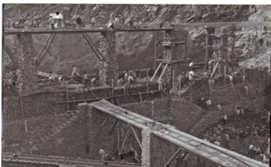
Figura 10. Construcción de los pilares para la presa del Chorro
