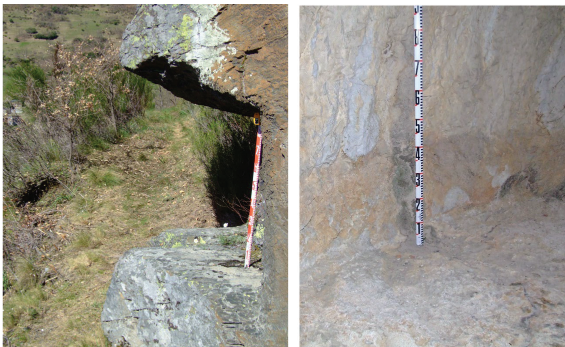
Figura 7. Excavación en semitúnel que limita la altura máxima de la lámina de agua (izquierda) y marca dejada por el agua en las calizas de la “cueva de la Gerijuela” perteneciente al canal Camino de Los Moros de Velilla del Río Carrión-Palencia (derecha)
