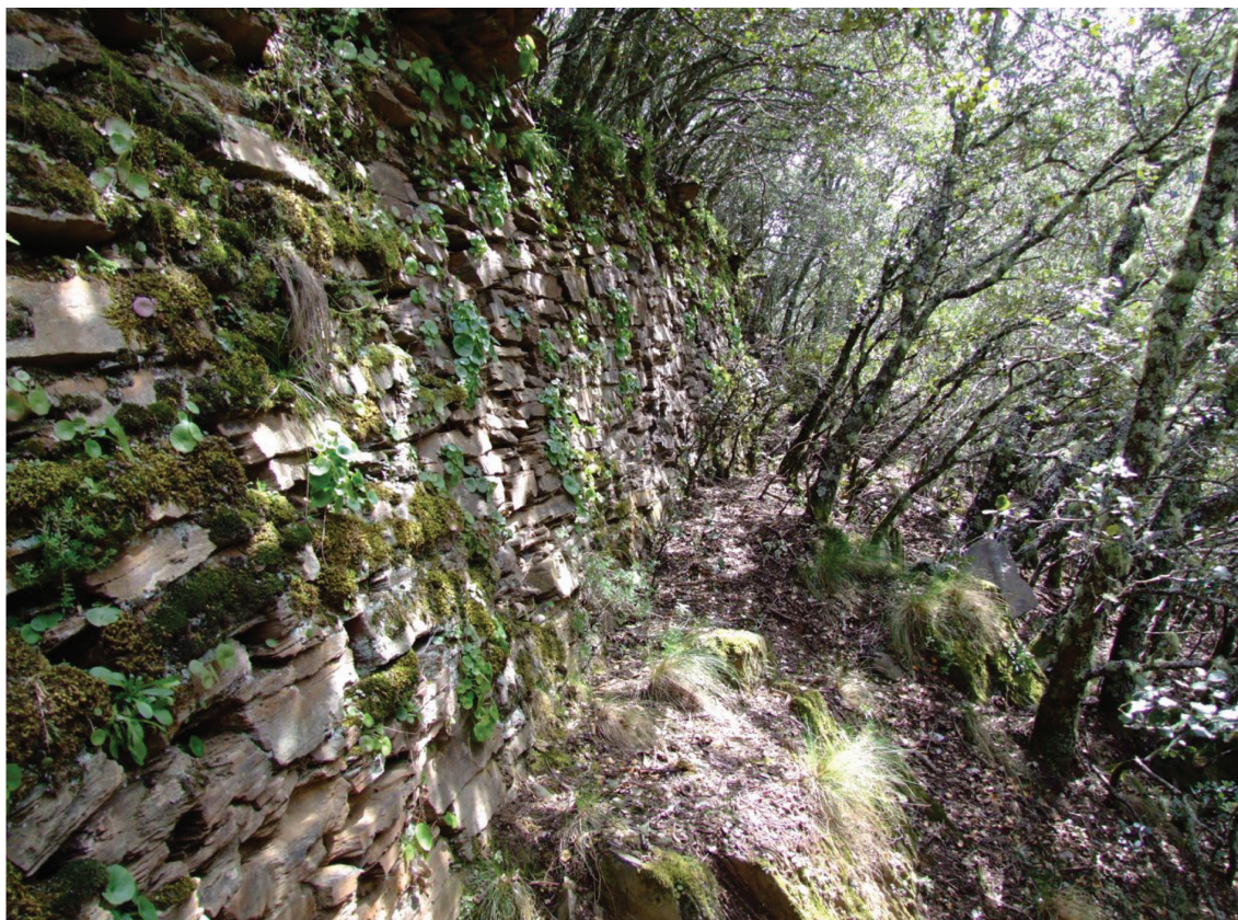
Figura 6. Muro de sostenimiento de un canal completamente oculto por la vegetación. Canal C-3 de Las Médulas en Río Cabo. Saceda-Castrillo de Cabrera (León)
