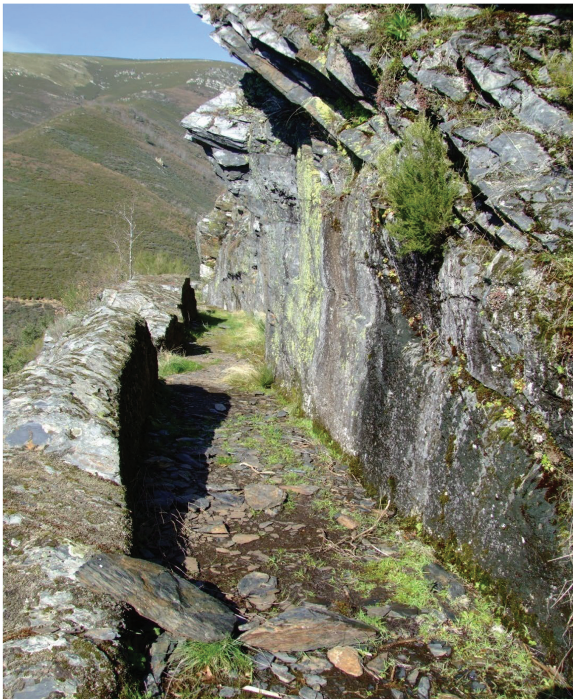
Figura 15. Corte en la roca del canal C-1 en Llamas de Cabrera (Benuza-León), integrado dentro de una ruta de senderismo: www.canalesromanos.es
