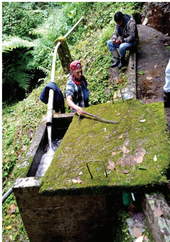
Figura 4. Faena comunitaria de limpieza de manantial para su posterior encajonamiento y de actual depósito de agua construido
