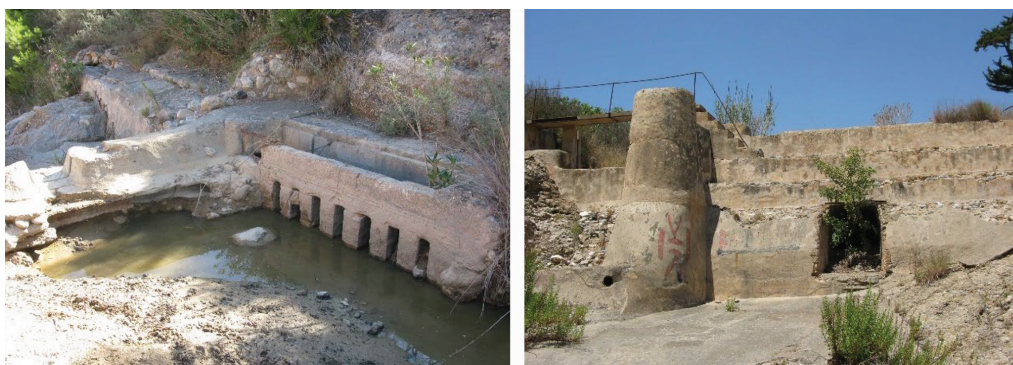
Figura 6. Vista del azud FV1 y el arranque del canal (izqda.) y del azud FV4 y su tubería de derivación (dcha.) ubicados en la rambla del Cabezo Negro
