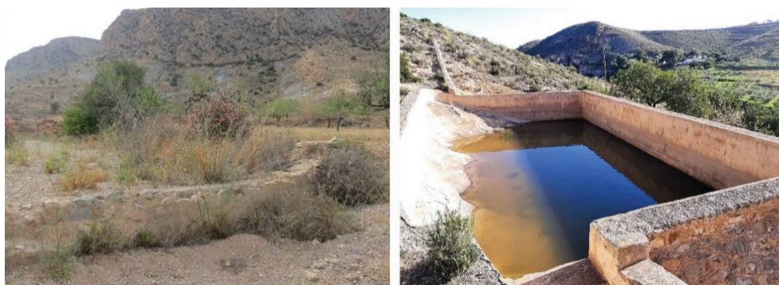
Figura 5. Azud de captación AR1 en la rambla de la Torre (izqda.) y vista de la balsa de captación abastecida por la escorrentía superficial (dcha.)
