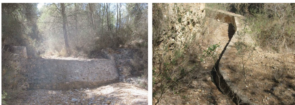
Figura 7. Azud ubicado en la rambla de Giménez hoy completamente aterrado (izqda.) y murete para la recogida de agua superficial en los márgenes de la rambla (dcha.)
