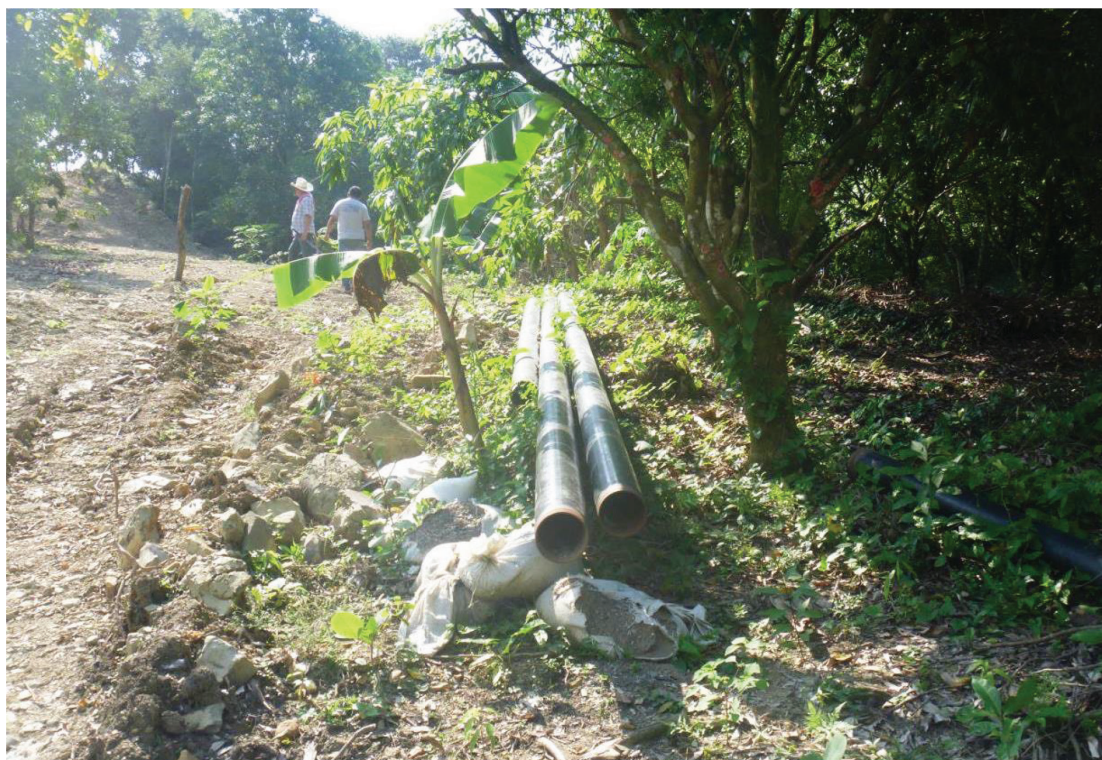
Figura 1. Segmento del desmonte y tramos de tubería
