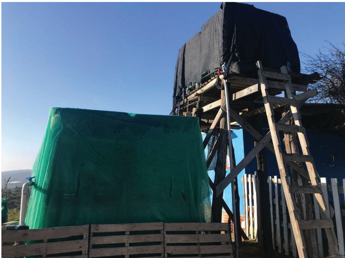
Figura 2. Estanques donde se almacena el agua, localidad de Nihue, Chile
