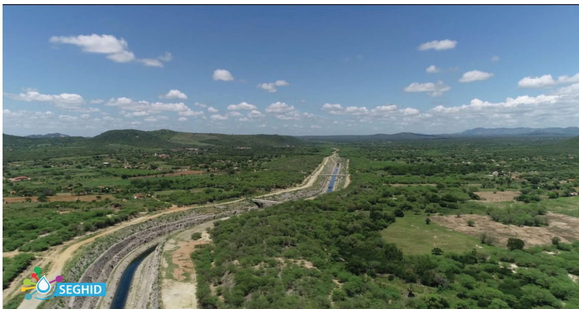
Figura 2. Eixo Leste da Transposição do São Francisco entre os estados de Pernambuco e Paraíba
