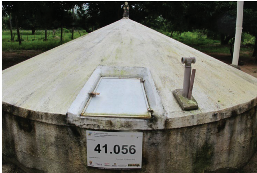
Figura 3. Cisterna de placa do P1MC construída em 2014 em Pernambuco
