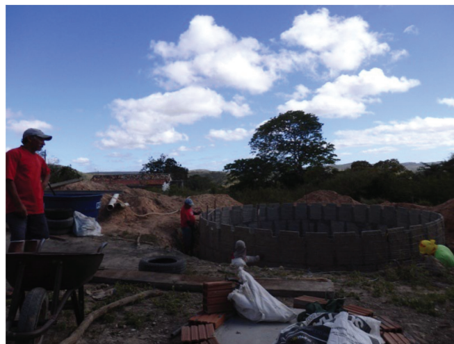
Figura 4. Cisterna sendo construída em 2017 em Pernambuco
