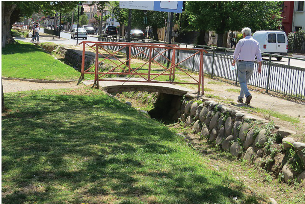
Figura 9. Pequeño puente de hormigón sobre la tradicional acequia urbana de paredes de bloques en las ciudades de San Felipe
