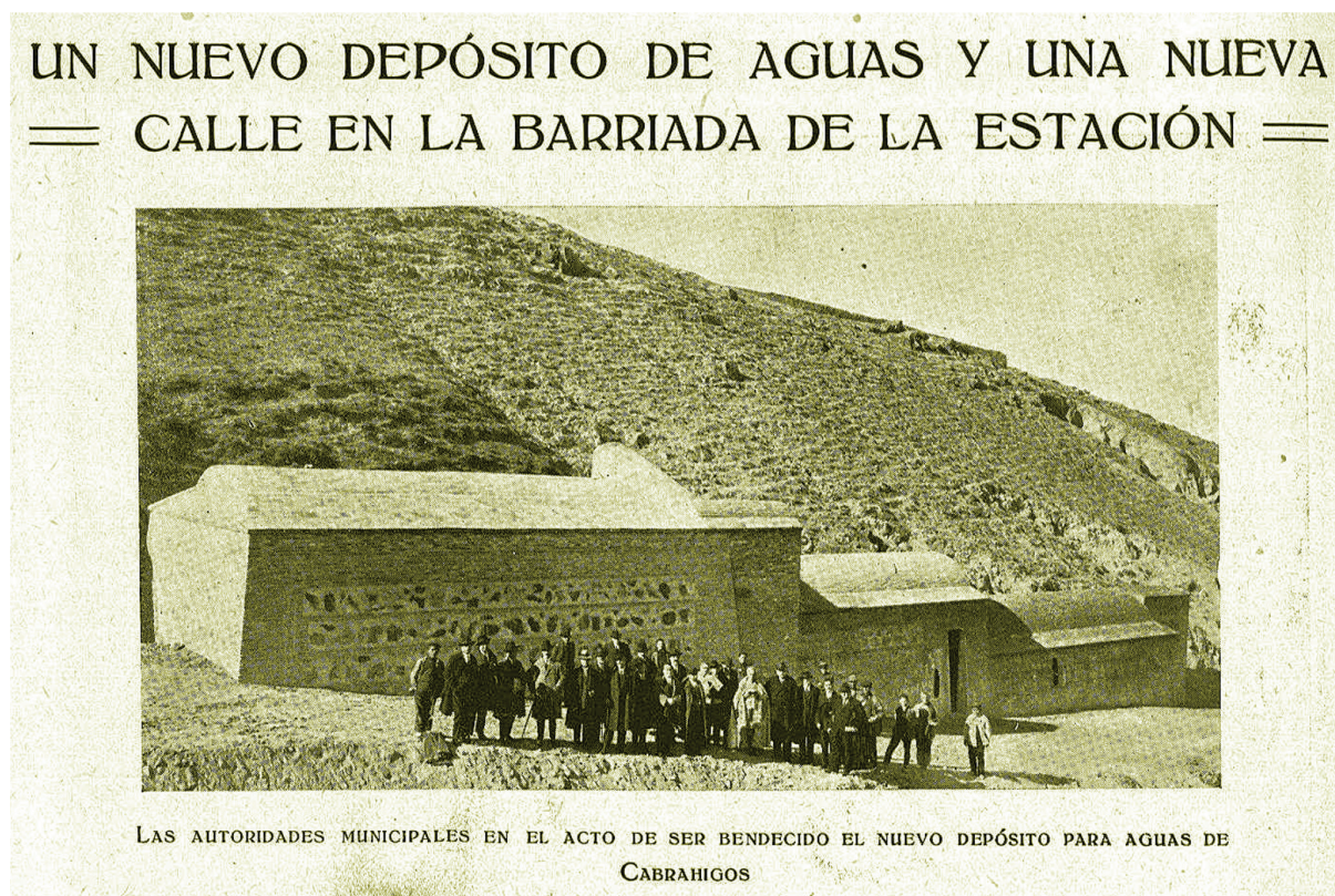
Figura 5. Construcción del nuevo depósito para la Fuente de Cbrahigos en 1924
