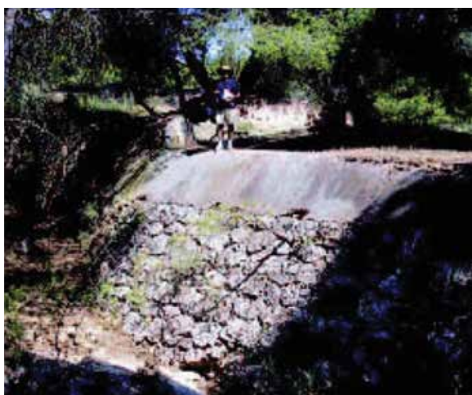
Figura 11. Galería inscrita en presa subálvea, al paso del qanat por la rambla de Las Tobarrillas en Yecla
