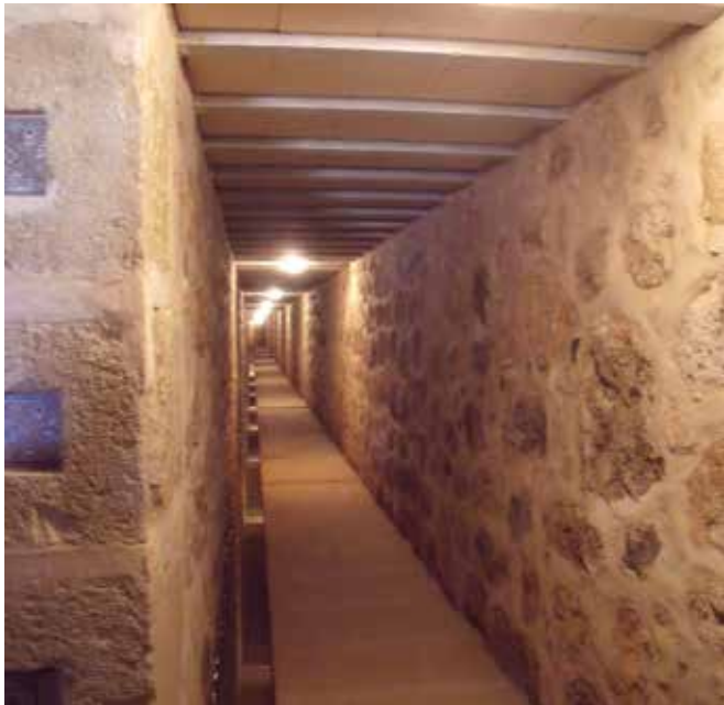
Figura 13. Rehabilitación del qanat de Casa Herrera (Jumilla)
