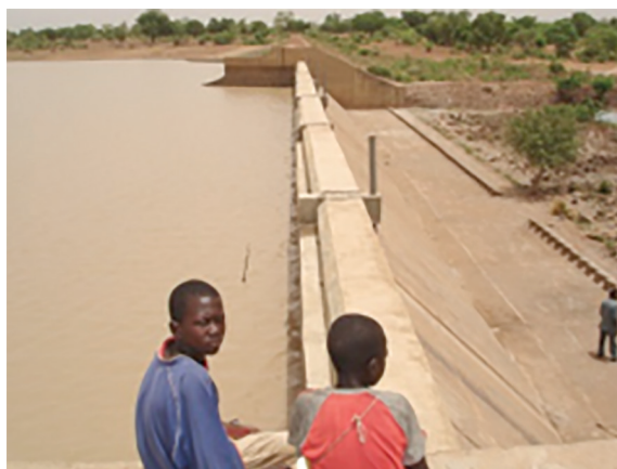
Figure 7. Déversoir en blocs fusibles construit au Burkina Faso
