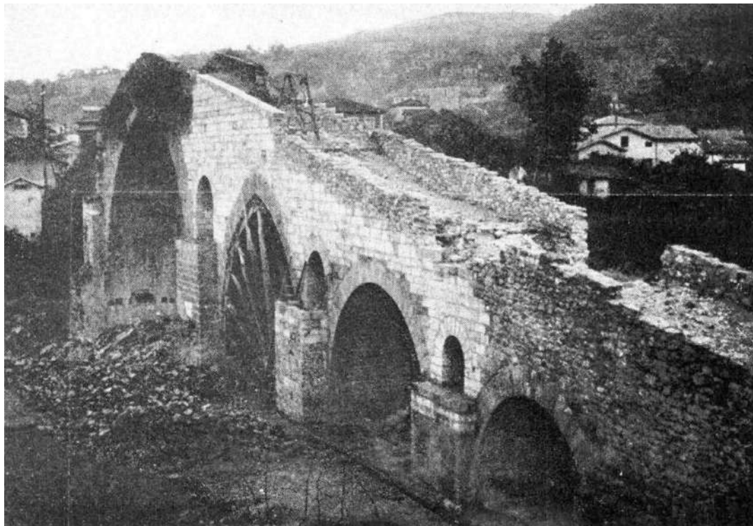
Figura 6. Reconstrucción de la fábrica con sillería bien y reconstrucción de pretilos con la mampostería del puente reutilizada
