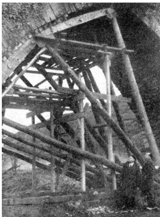
Figura 5. Trabajos de encimbrado del arco apuntado del lateral occidental (Luis Menéndez-Pidal junto a la pila, a la derecha, con boina)
