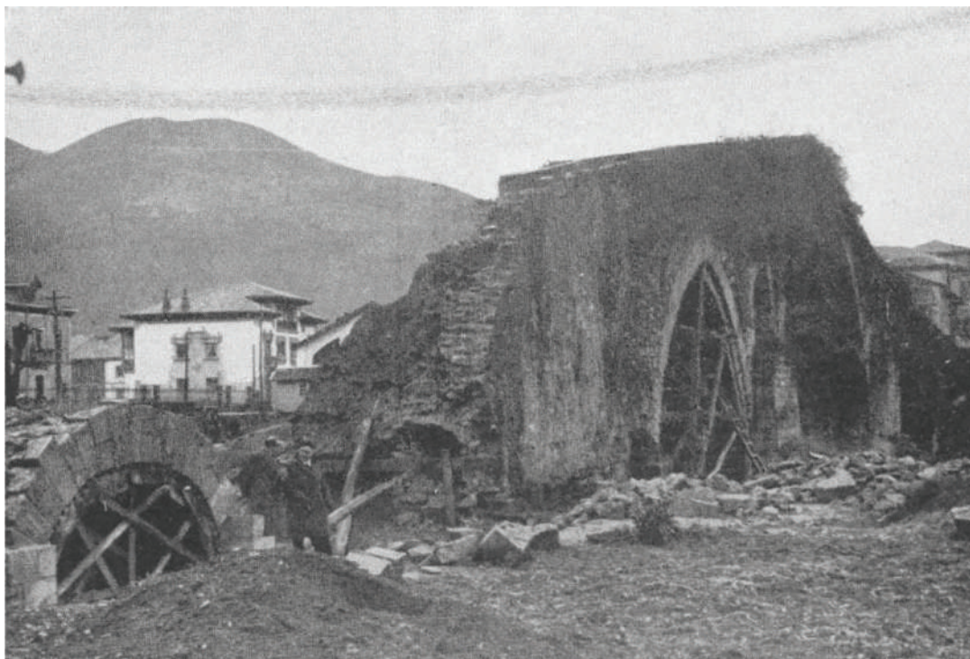
Figura 4. El puente de Cangas de Onís durante los trabajos de encimbrado y reconstrucción de los arcos occidentales. Luis Menéndez-Pidal junto a la 2ª pila desde la derecha, con boina
