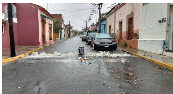
Figura 3. Taponamiento por basura en boca tormenta
