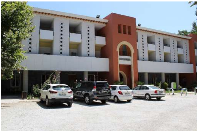
Imagen 2. Edificio principal del Balneario de Alhama de Granada
