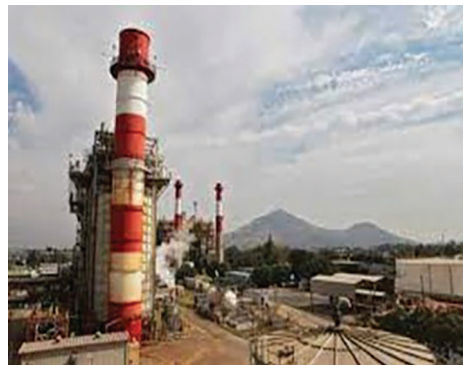
Figura 11. Fotografía de la termoeléctrica de Renca, emplazada en el distrito industrial mapochino
