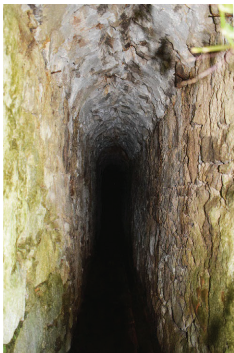
Figura 4. Minas o qanats para la extracción de agua subterránea en el Palacio Nacional de Sintra, Portugal
