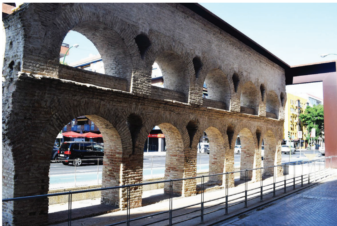
Figura 2. Acueducto de los Caños de Carmona, Sevilla
