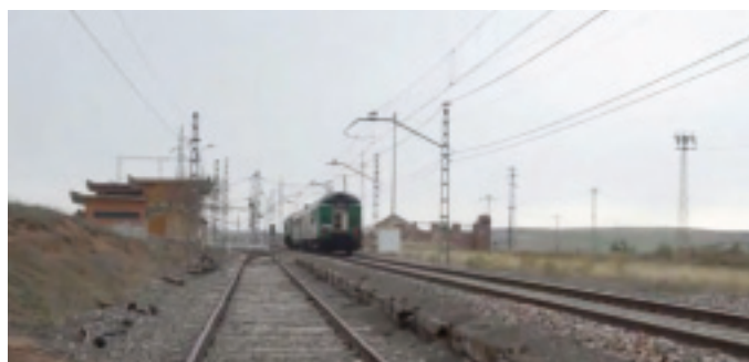
Figura 4. Deterioro en Grañena imagen capturada de: https://www.youtube.com/watch?v=pERXxxMW1ts
