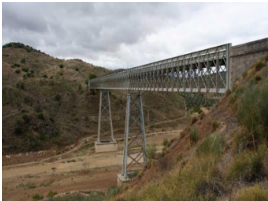
Figura 18. Viaducto sobre el Arroyo de la Piedra del Águila, construido por los discípulos de Eiffel: Daydé y Pille. Fotografía obtenida de la web Vive la vía- vías verdes , http://www.viasverdes.com/itinerarios/itinerario.asp?id=67
