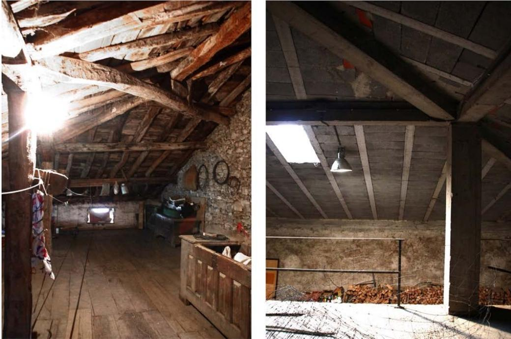
**Imagen 4.** Estructura de la cubierta de Aitzkorbe Azpikua en la actualidad. A la izquierda la mitad que sobrevivió a las llamas, a la derecha la mitad reconstruida después del incendio (Elaboración propia. Marzo de 2016).
